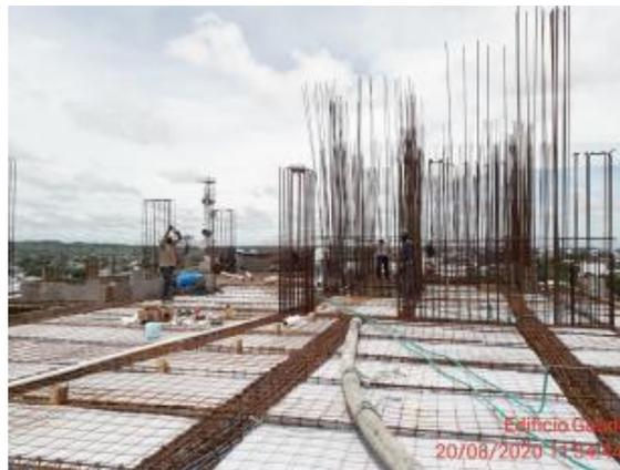
Anexo A: 4 Armado de acero, enfrado e instalación de tubería eléctrica.
