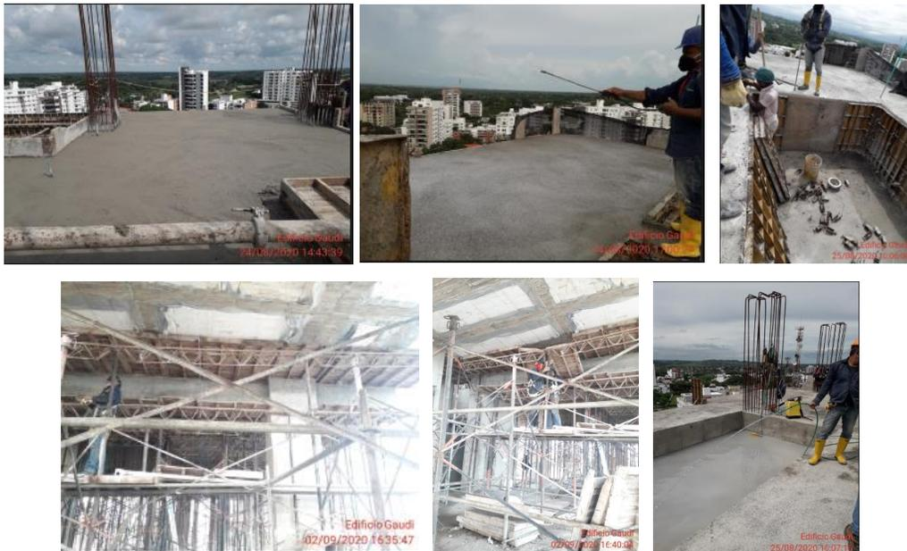
*Anexo A: 8 Aplicación de Antisol, desencofrado e hidratación en losa*
