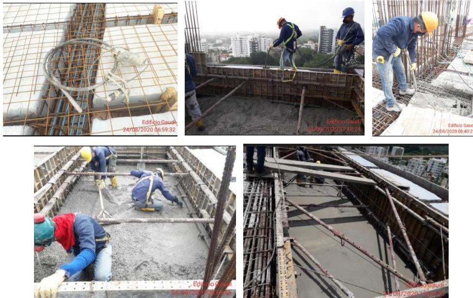
*Anexo A: 7 Vibrado y allanado del concreto*
