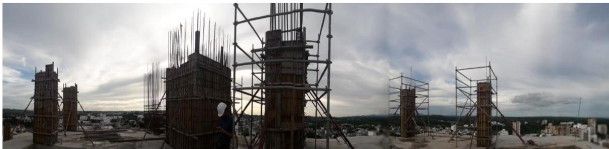
*Anexo A: 10 Figurado, armado de acero y encofrado de columnas y muros pantallas*
