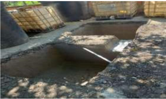
*Ilustración 2. Construcción de piscinas para lodos*
