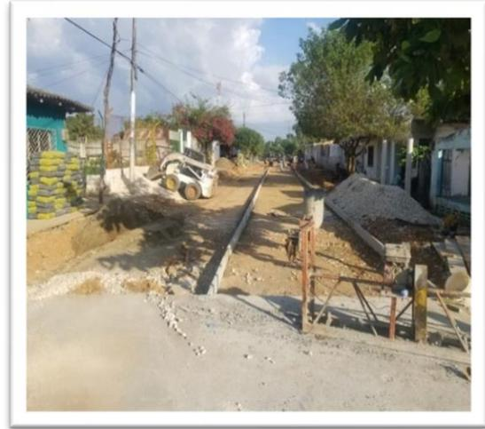
**Imagen 3.** Construcción de pavimento rígido en diferentes calles y carreras en la cabecera municipal de San Onofre - sucre
