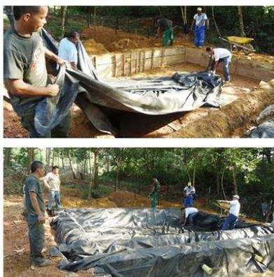
Imagen 24. Instalación de la geomembrana a la cama 2
