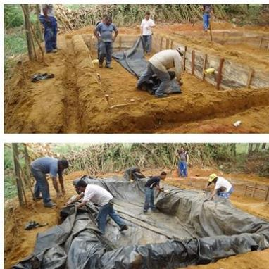
Imagen 23. Instalación de la geomembrana a la cama 1
