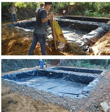
Imagen 25. Relleno de zanjas de anclaje con grava
