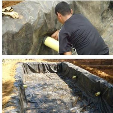
Imagen 26. Amarre de tuberías a la geomembrana
