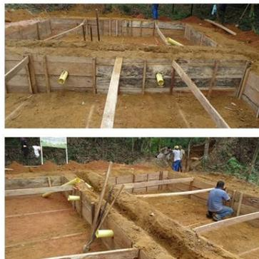
Imagen 21. Instalación de tubería
