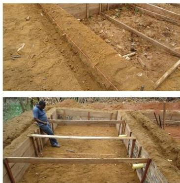
Imagen 22. Realización de las zanjas de anclaje
