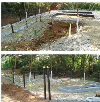
Imagen 29. Instalación del filtro y encerramiento del proyecto
