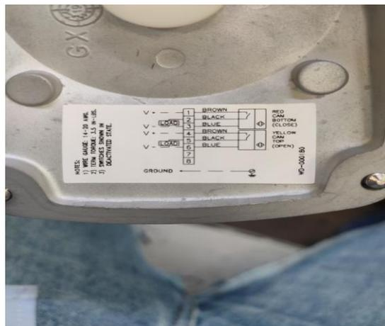
Fig 10: conexiones del posicionador
