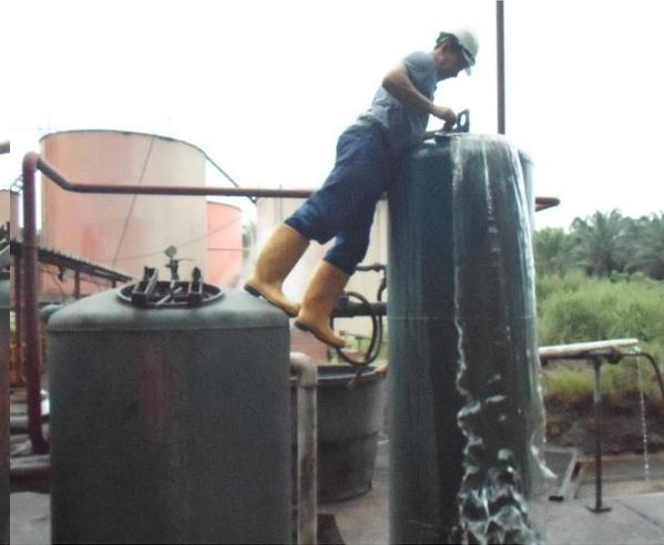
Imagen No. 20: Mantenimiento del tanque suavizador.
