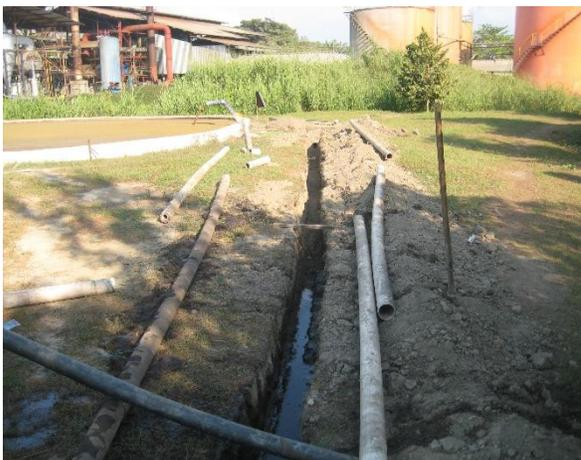
Imagen No. 5: Mantenimiento a tuberías de recirculación.
