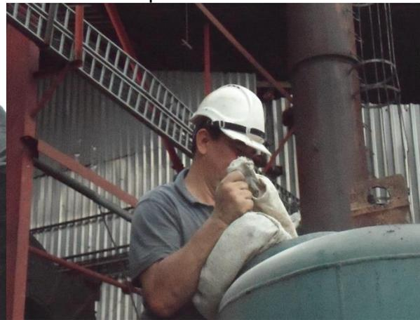
Imagen No. 22: Aplicación de resina al tanque suavizador.
