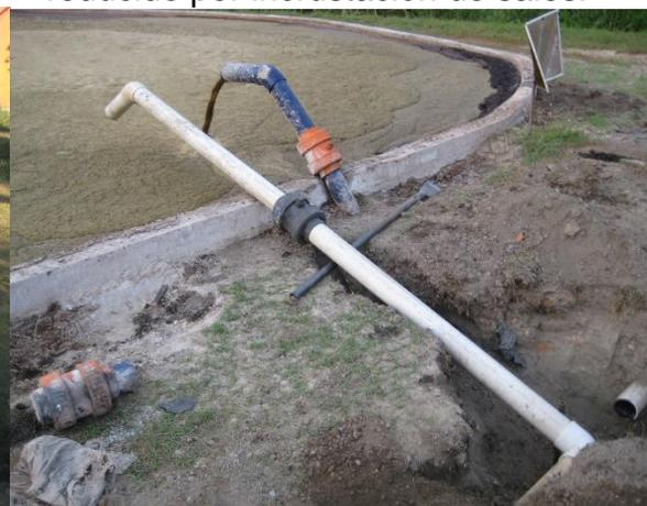
Imagen No. 6: Instalación de nuevos tramos de tuberías para recirculación.
