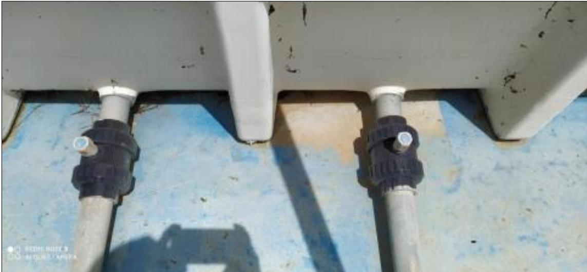
***Imagen No 8: todas las válvulas de la planta están cristalizadas. Tomado propio.***
