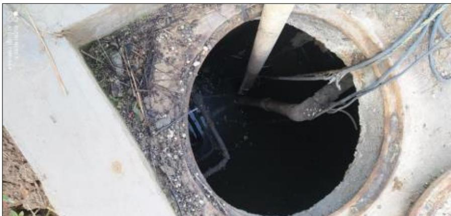
**Imagen No 5.: pozo séptico. Manera incorrecta de bombear agua a la PTARD.
