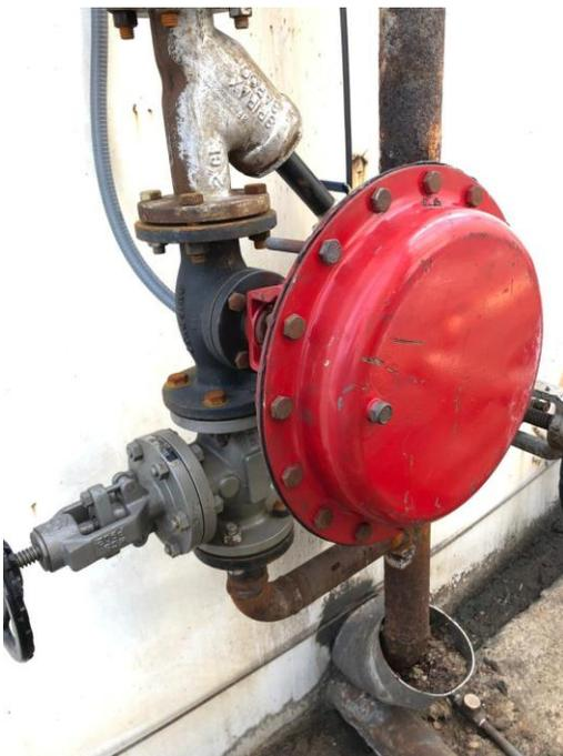
Imagen 7. Montaje de válvula de control.
