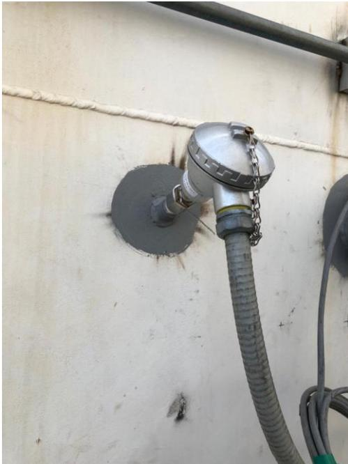
Imagen 6. Montaje de pt100 en el tanque.
