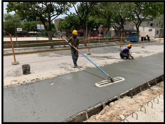
Figura 47. Acabado superficial con flotador
