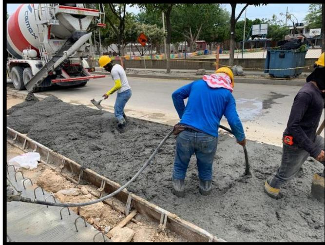
Figura 45. Vibrado con vibrador de punta
