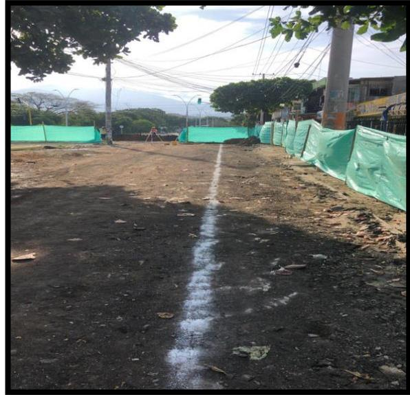
*Figura 8. Trazado de los ejes de la vía con cal.*
