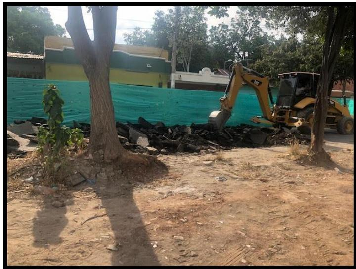
*Figura 2. Retroexcavadora demoliendo pavimento flexible con la pala*
