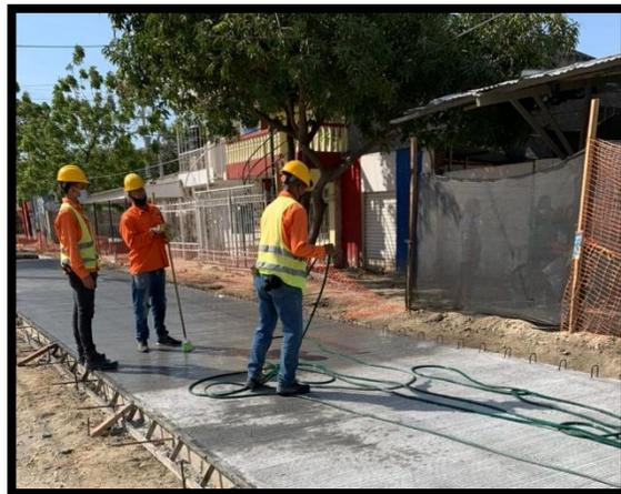
*Figura 55. Humectación de placas con manguera*
