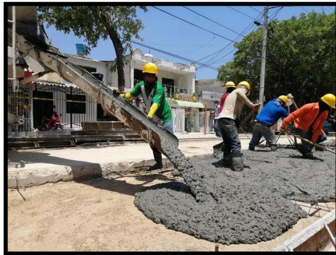
*Figura 43. Vaciado del concreto*
