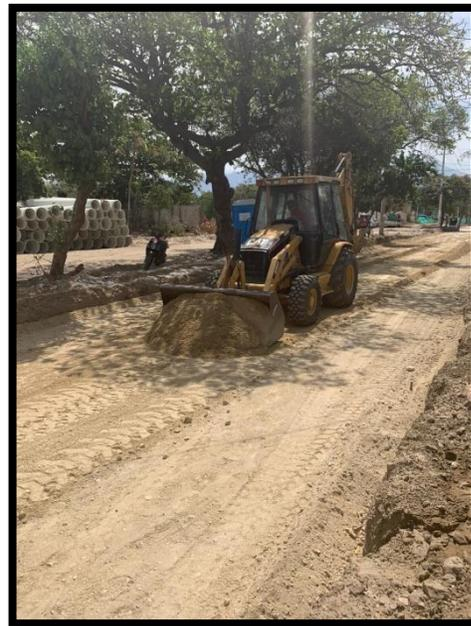
*Figura 17. Extensión de material con retocargadora*
