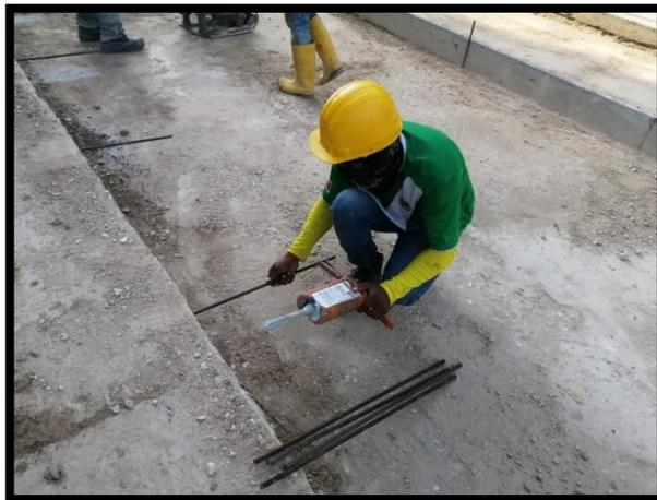
Figura 31. Anclaje de barras de amarre con epóxico Sika
