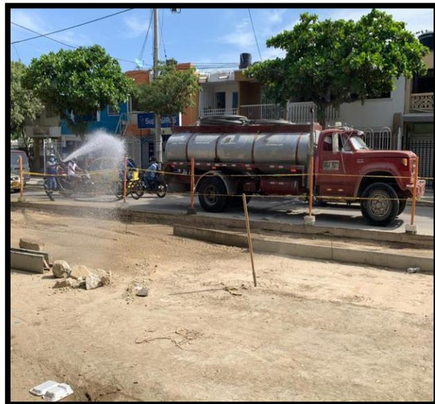
Figura 11. Humectación con carrotanque
