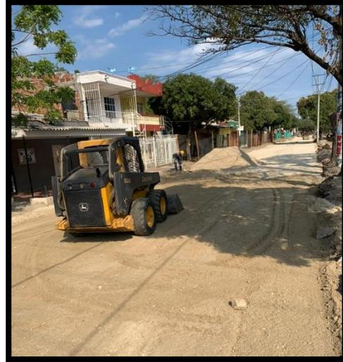
*Figura 18. Extensión del material con minicargador*
