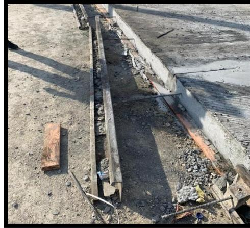
*Figura 53. Desencofrado de placas*
