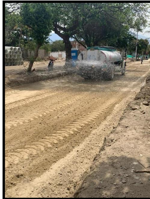
*Figura 19. Humectación del material extendido para subbase*
