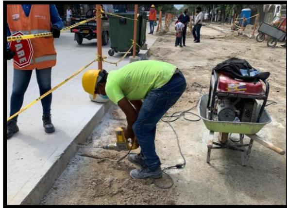
Figura 30. Perforación en pavimento existente para anclaje de barras de amarre
