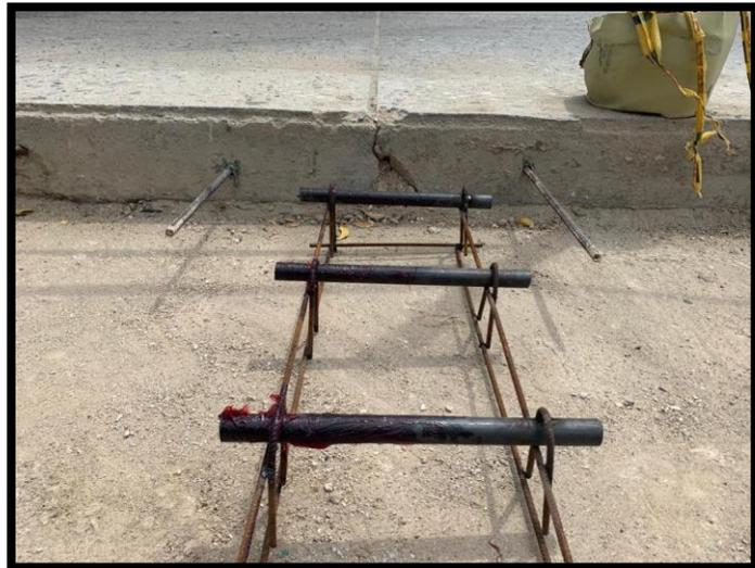
*Figura 26. Canastillas con dovelas engrasadas a la mitad en dirección del flujo vehicular, separadas 30cm de las barras de transferencia para libre movimiento dentro de la placa*
