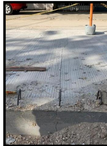
*Figura 60. Fisura en placa de concreto*
