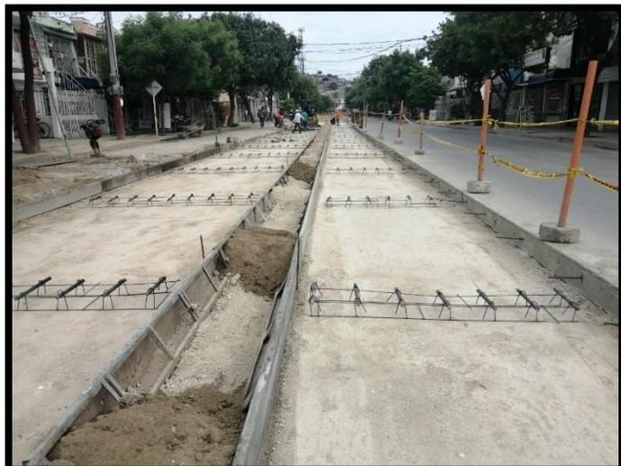
*Figura 27. Dovelas ubicadas en las juntas transversales de la calzada*
