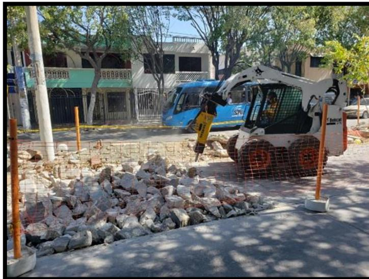
*Figura 5. Minicargador demoliendo pavimento rígido con taladró*
