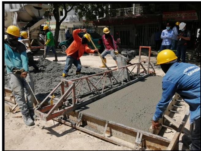
*Figura 44. Vibrado con regla vibratoria*
