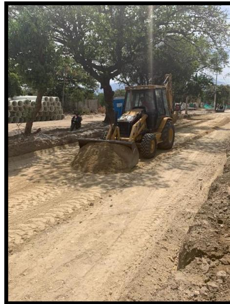
*Figura 17. Extensión de material con retocargadora*
