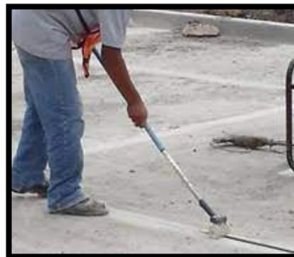
Figura 57. Colocación del cordón para las juntas
