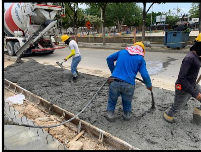
Figura 45. Vibrado con vibrador de punta
