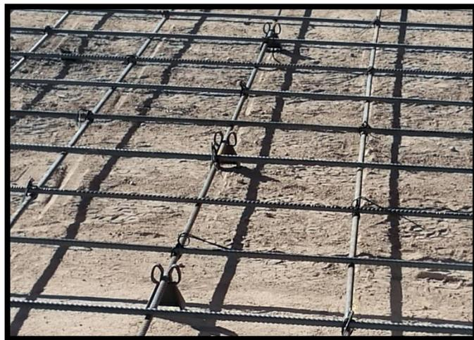
*Figura 37. Silletas para la altura del refuerzo de acero*
