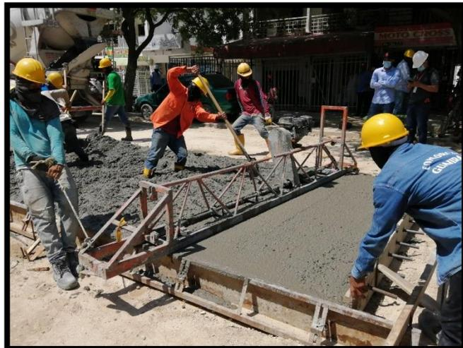
*Figura 44. Vibrado con regla vibratoria*
