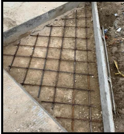
*Figura 36. Losa triangular para los cruces en las boca-calles.*
