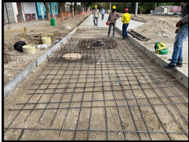
Figura 32. Refuerzo para losa con longitud 24 veces mayor al espesor
