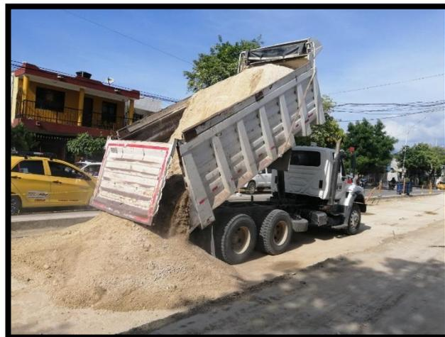
*Figura 14. Descargue de material seleccionado para sub base*
