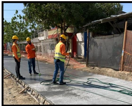
*Figura 55. Humectación de placas con manguera*
