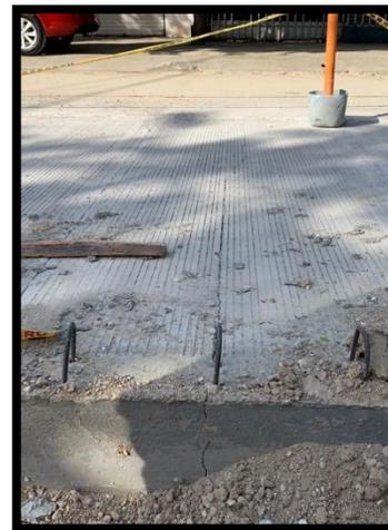
*Figura 60. Fisura en placa de concreto*
