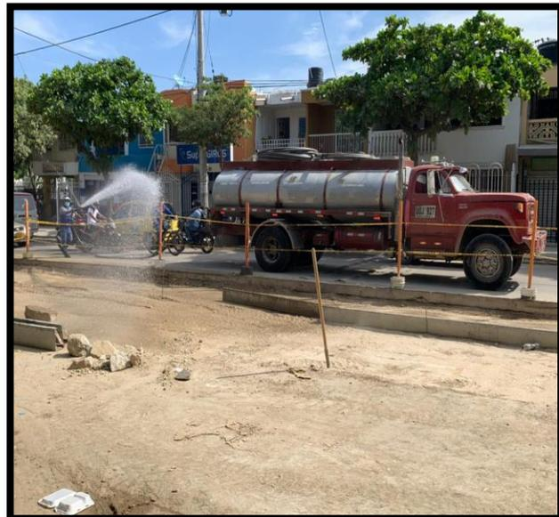
*Figura 11. Humectación con carrotanque*
