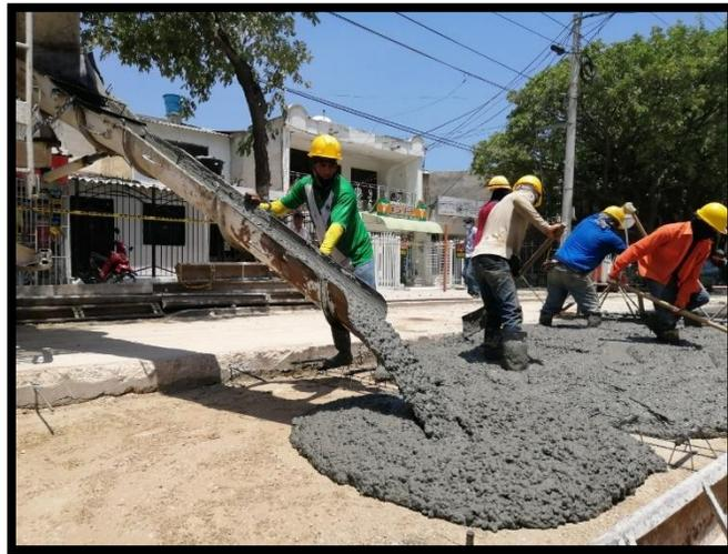
*Figura 43. Vaciado del concreto*
