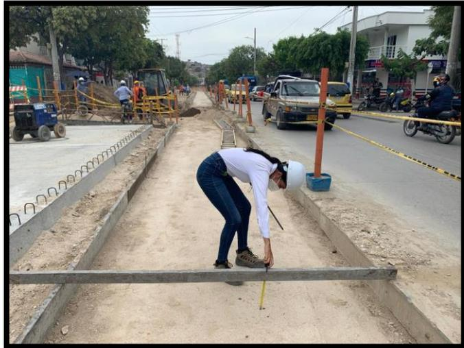
*Figura 24. Chequeo de espesor con regla sobre formaleta y pavimento existente*
