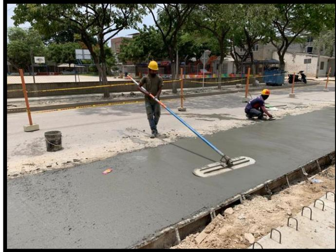
*Figura 47. Acabado superficial con flotador*
