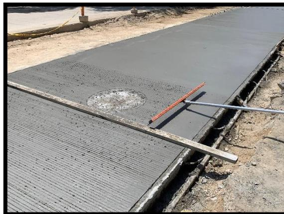
*Figura 50. Rayado del concreto con peine metálico*
