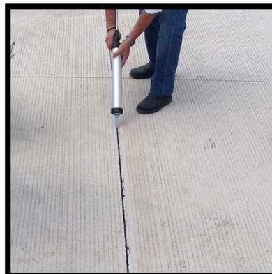
Figura 58. Aplicación del sello en la junta
