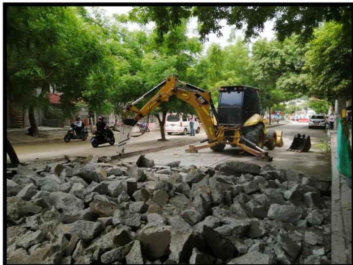
*Figura 3. Retroexcavadora demoliendo pavimento rígido con taladro*
