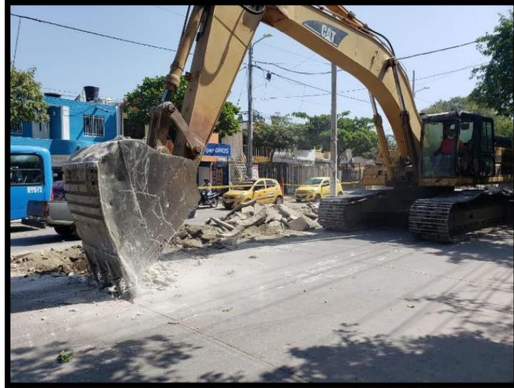
*Figura 4. Excavadora demoliendo pavimento rígido con la pala*
