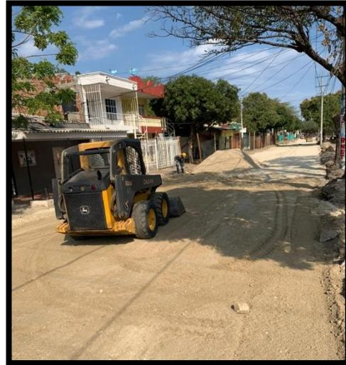
*Figura 18. Extensión del material con minicargador*
