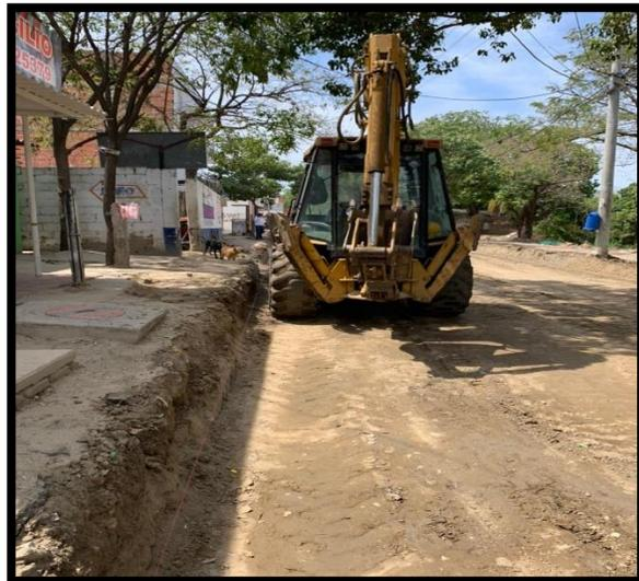
Figura 9. Nivelación de la sub rasante con la retroexcavadora
