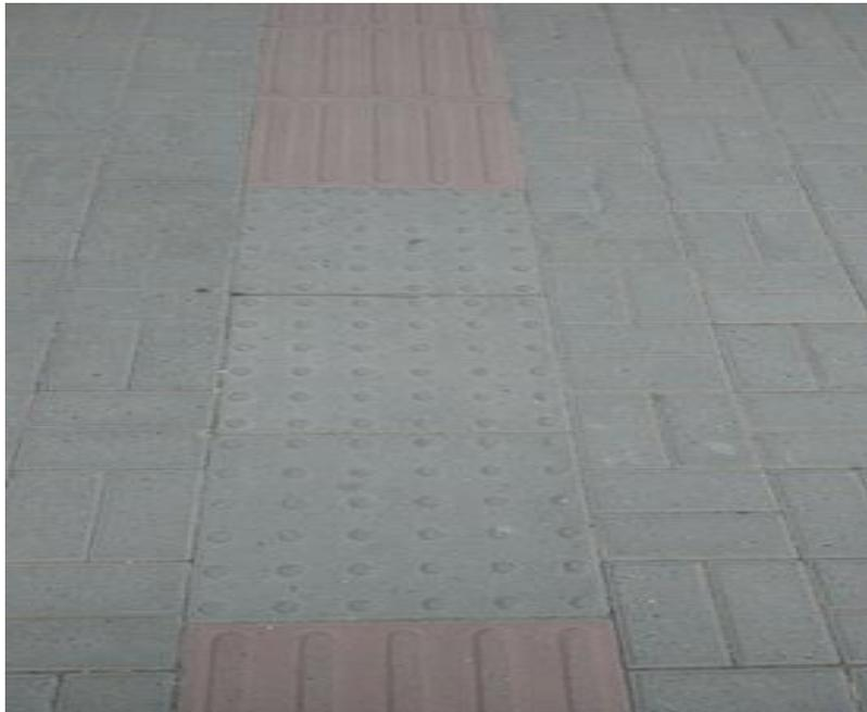
*Ilustración 21. Estilo circular de baldosas podo táctiles*
