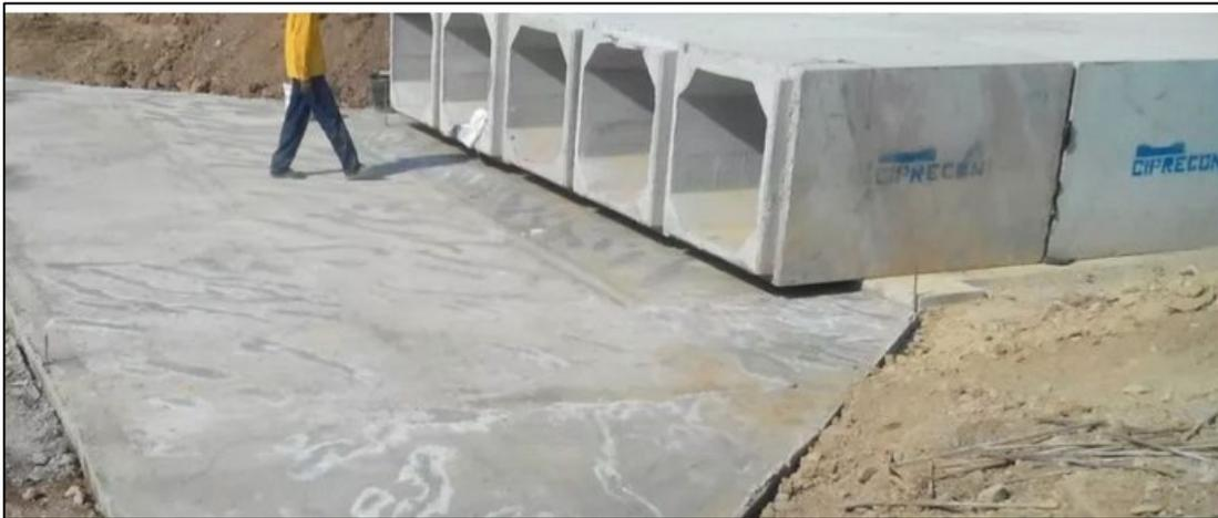
*Figura 3. Box culvert Prefabricado*
