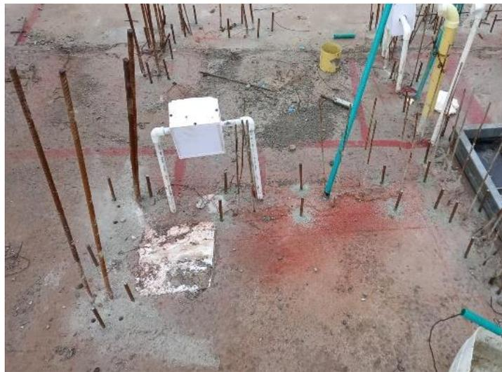
Este proceso termina con la colocación de los taches externos en los muros, cuando las formaletas son posicionadas y fijadas, todo esto para restringir el movimiento de las mismas.
