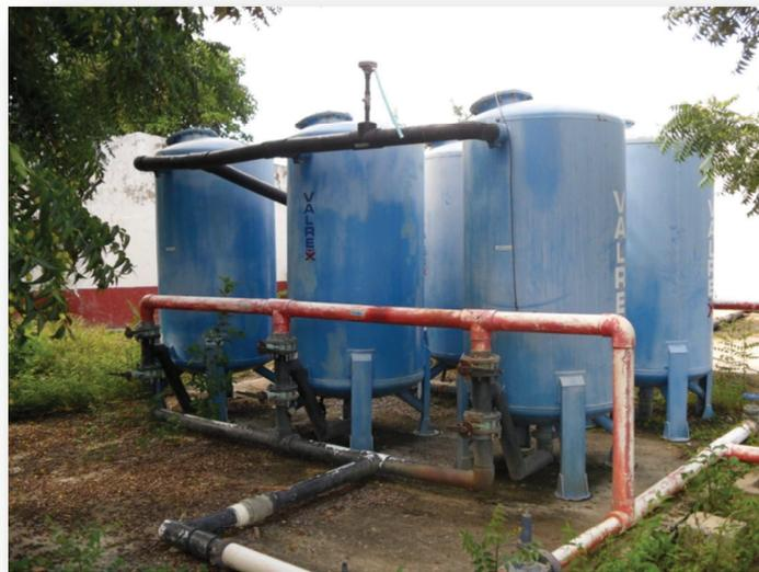
**Foto 6.** Filtros ubicados en la planta de tratamiento. Municipio de Zapayán
