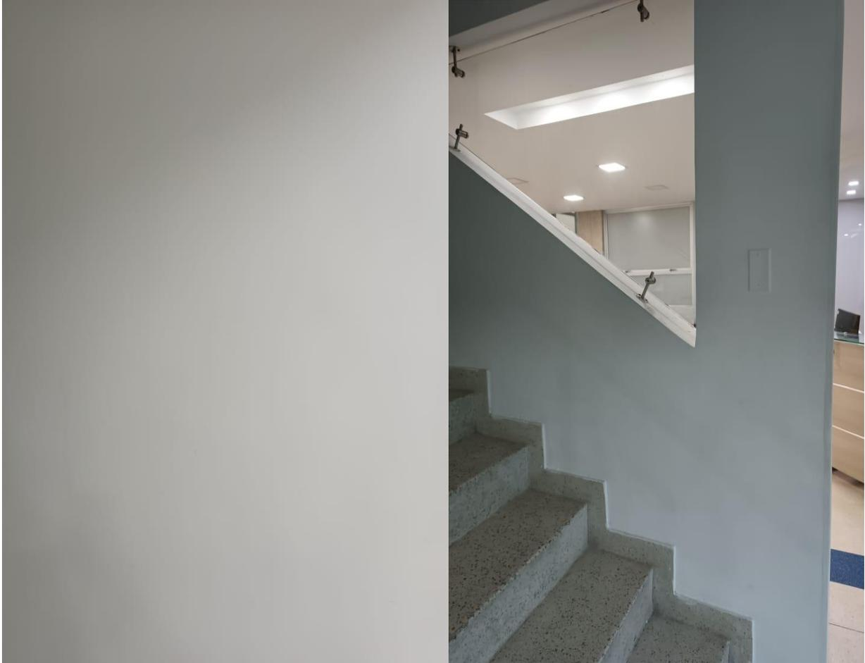
**Imagen:** Poca señalización y no cumplía con la norma de fotoluminiscencia. **Fuente:** Elaboración Propia.
