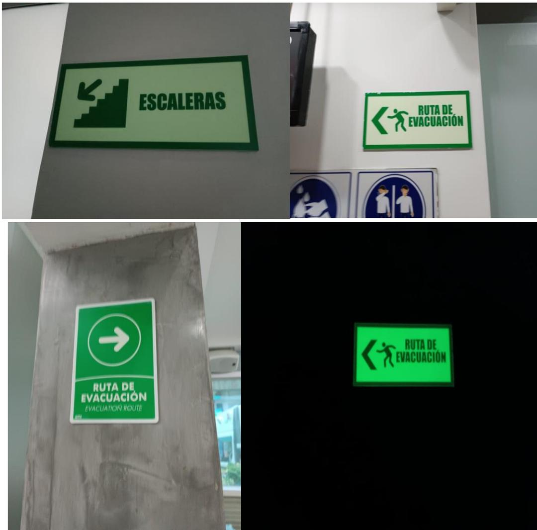
**Imagen:** instalación de señalización que cumple con la norma de fotoluminiscencia. **Fuente:**Elaboracion Propia.
