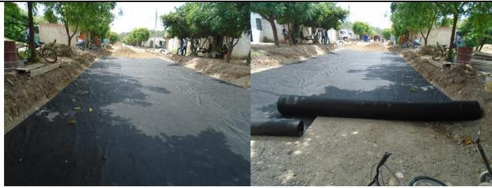
Extendida y compactación de subbase e instalación de geomalla.
