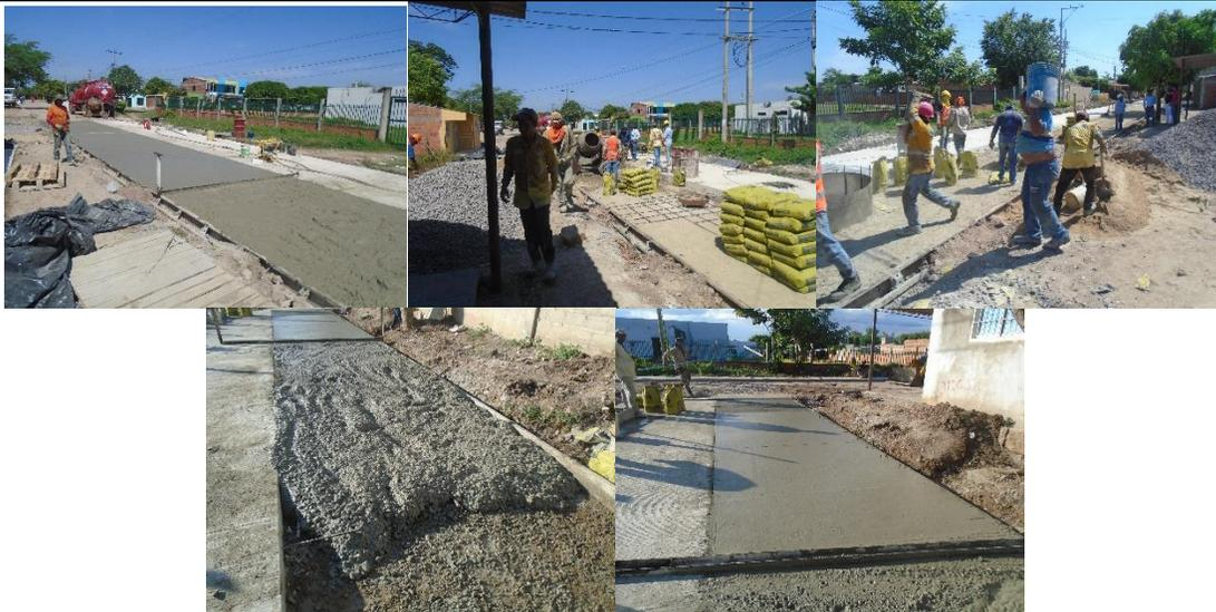
Fundida de losas de concreto de 4000 psi
