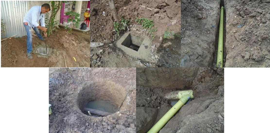
Instalación de alcantarillado sanitario e instalación de cajillas y pozos de inspección
