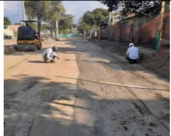
Garantizar que la subrasante de la obra cumpla con todas las condiciones para llevar a cabo la fundida del concreto. (Ensayos de densidad, saturación, compactación, etc).
