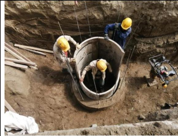
Supervisión en el proceso constructivo para la instalación de Manholes del sistema de alcantarillado y drenaje de aguas lluvias. Verificar que se cumplan con todas las especificaciones, cotas, y diseños.
