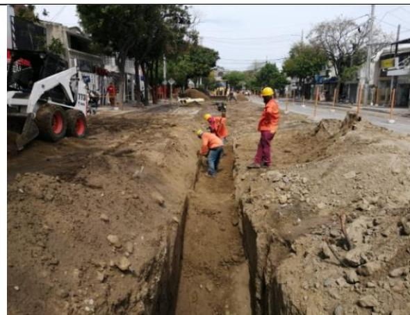
Supervisión en el proceso constructivo para la instalación de redes húmedas de las obras contratadas por el SETP. Hay que velar que el contratista cumpla con todo lo estipulado del PMA (Plan de manejo ambiental) y PMT (Plan de manejo de tránsito) del contrato de obra.
