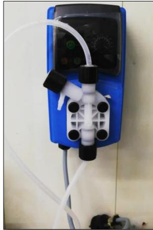
Ilustración 8. Sistema de dosificación
