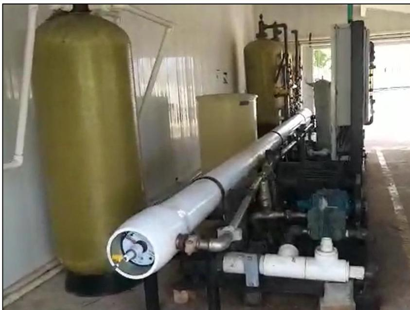
Ilustración 3. Osmosis inversa en mal estado.
