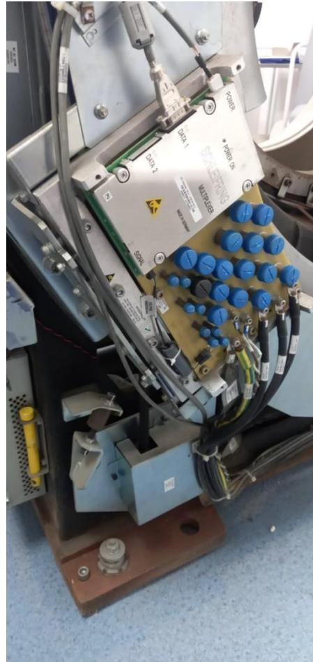
**Imagen 8.** Limpieza del anillo Slip Ring y cambones causante de error en el sistema de lectura y captura de imágenes.
