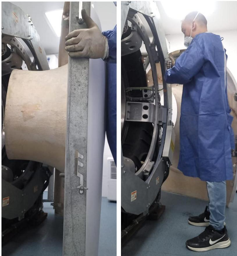
**Imagen 7.** Durante el proceso de mantenimiento al tomógrafo se retiran las tapas laterales, superiores y posterior para dar apertura del Slip Ring, donde se realizará la limpieza.
