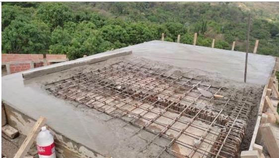
Revisión armada y fundida de losa maciza para tanques
