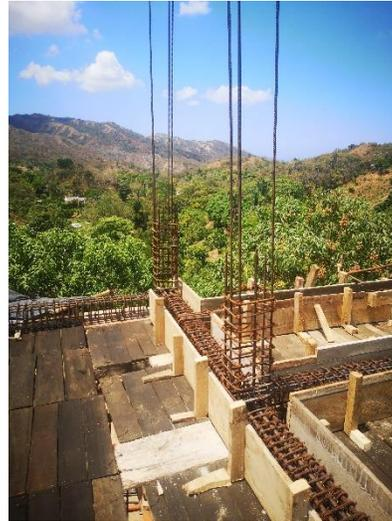
Inspección armado vigas de entrepiso para losa de Metaldeck
