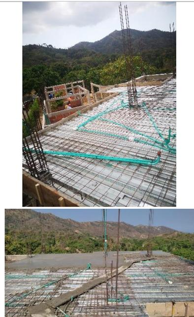
Revisión instalación láminas de Metaldeck y fundida de la placa
