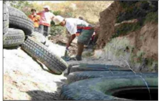
Ilustración 19. Proceso de alineación de las llantas
