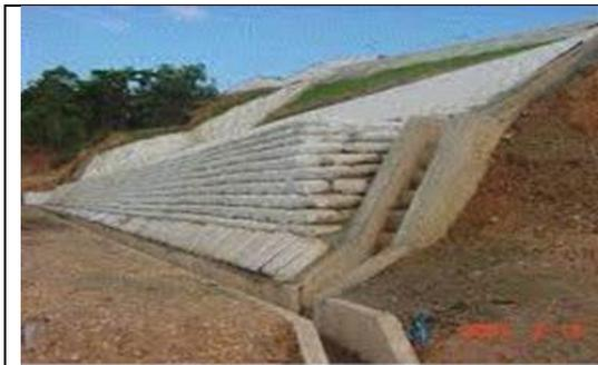
Figura 10. Combinación de muros flexibles, drenaje superficial y profundo y protección vegetal practicada con muy buenos resultados en la selva nortiana
