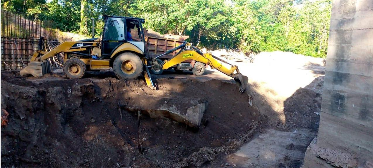
***Excavación para zapata del puente vehicular El Enneal***
