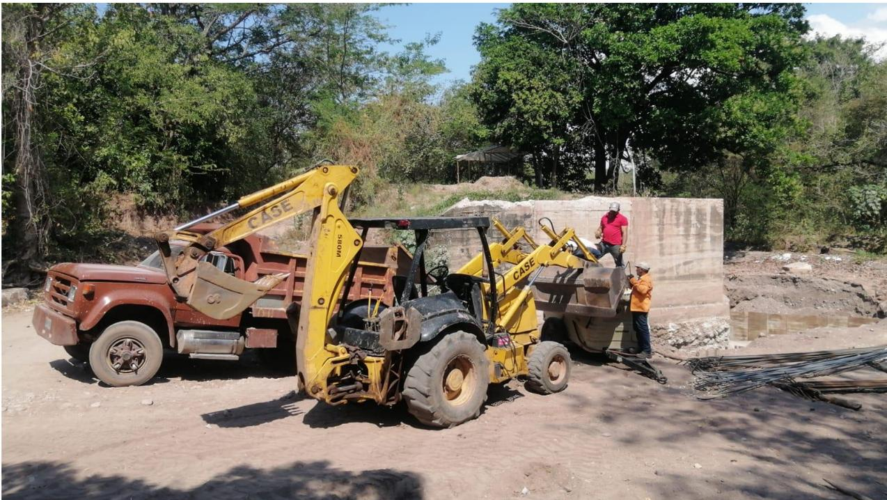
***Retiro de material excavación del puente vehicular El Enneal***
