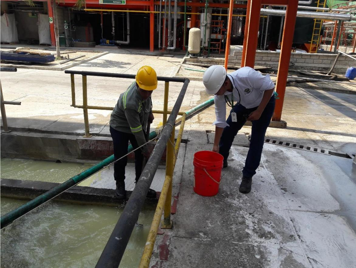
*Ilustración 15 Realizando mediciones de parámetros de vertimiento y caudal.*
