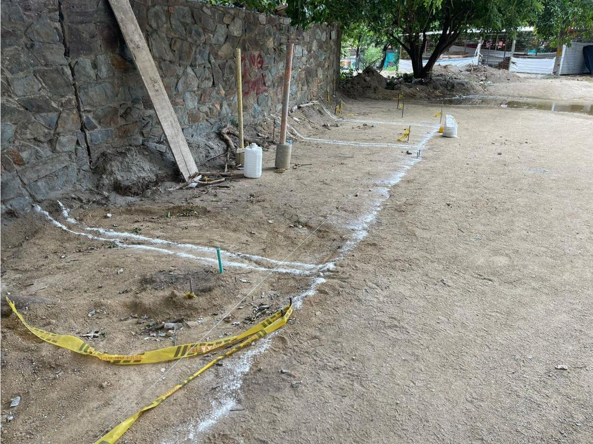
*Ilustración 13. Demarcación de vigas de cimentación - Subestación*
