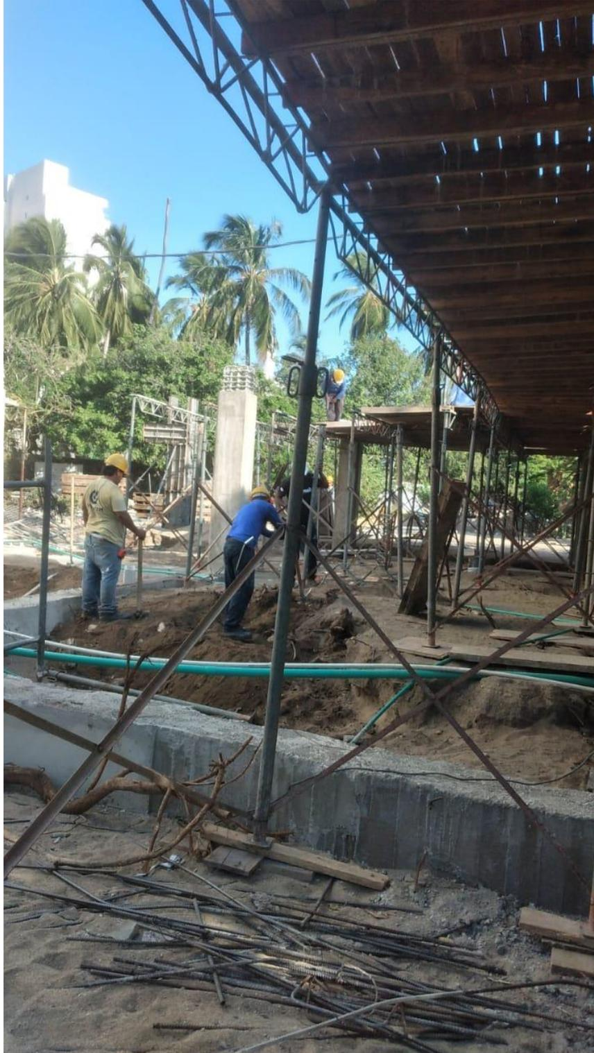
*Ilustración 21. Armado de placa segundo piso Torre de Parquaderos*
