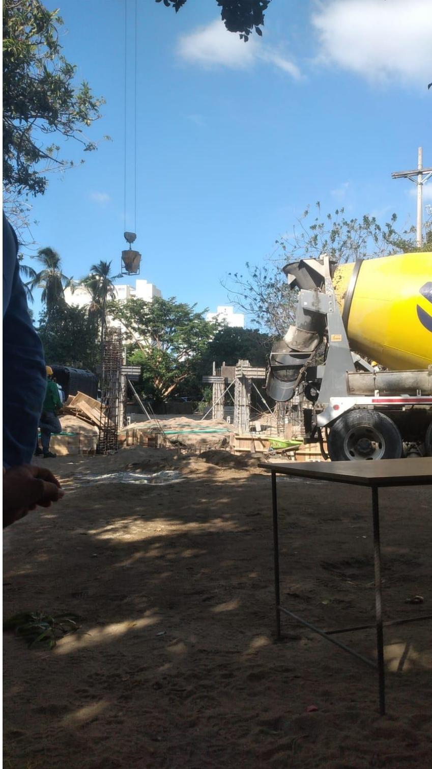
*Ilustración 22. Fundida de columnas de torre de parqueaderos*
