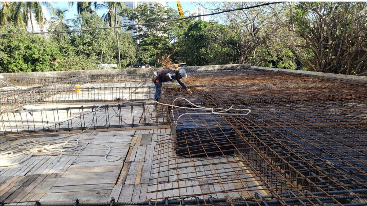
*Ilustración 46. Armado de placa de parqueaderos*
