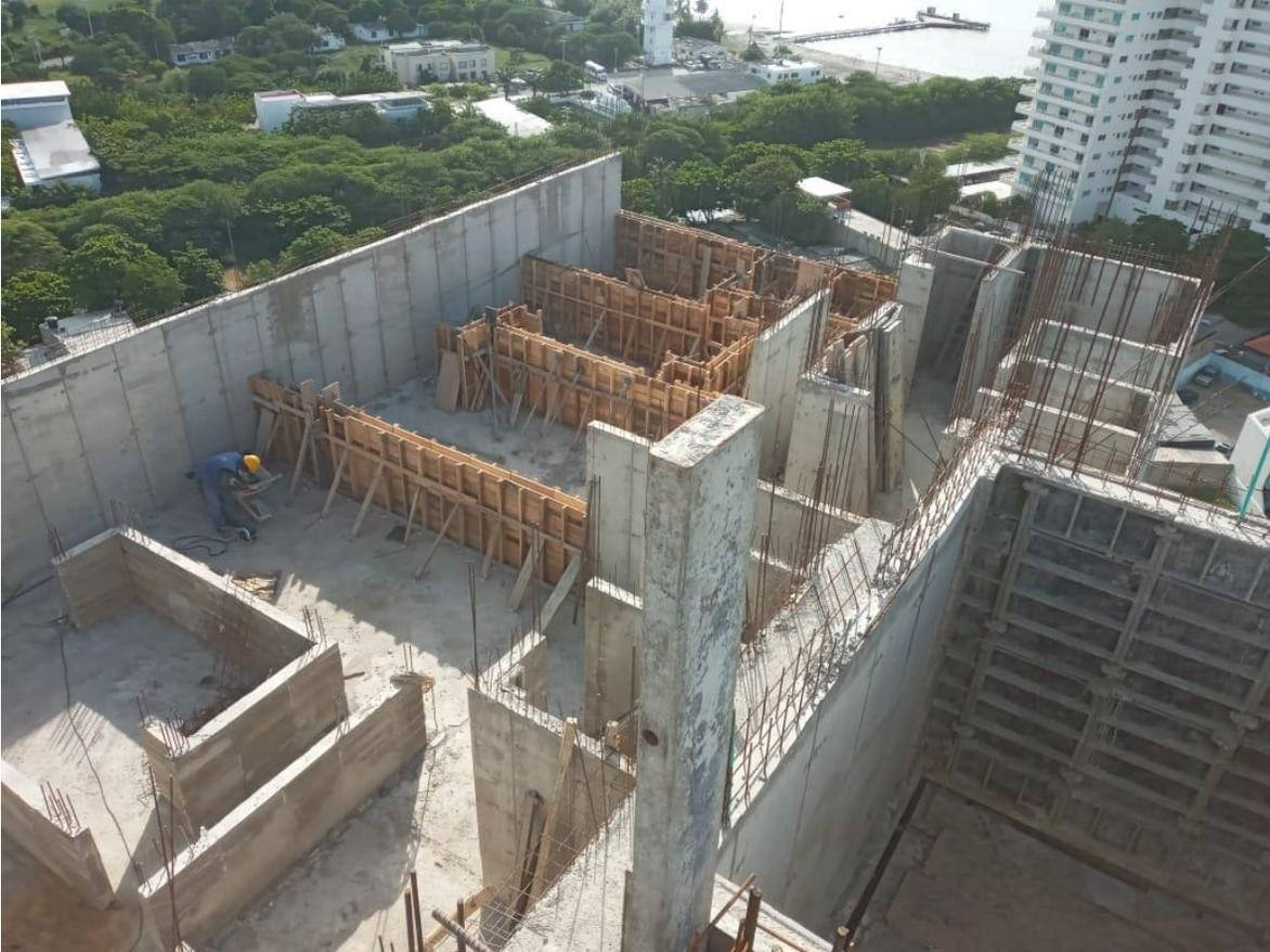
*Ilustración 11. Armado de muros bajos para piscina de adultos*
