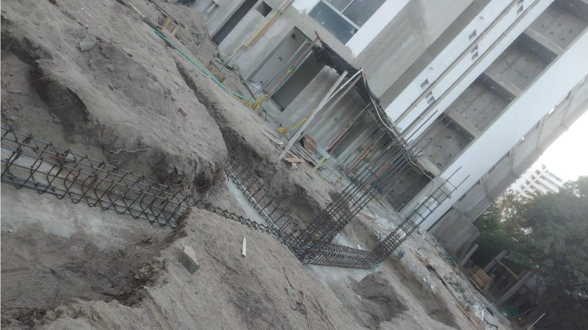
*Ilustración 24. Armado de Vigas - Torre de parqueaderos.*
