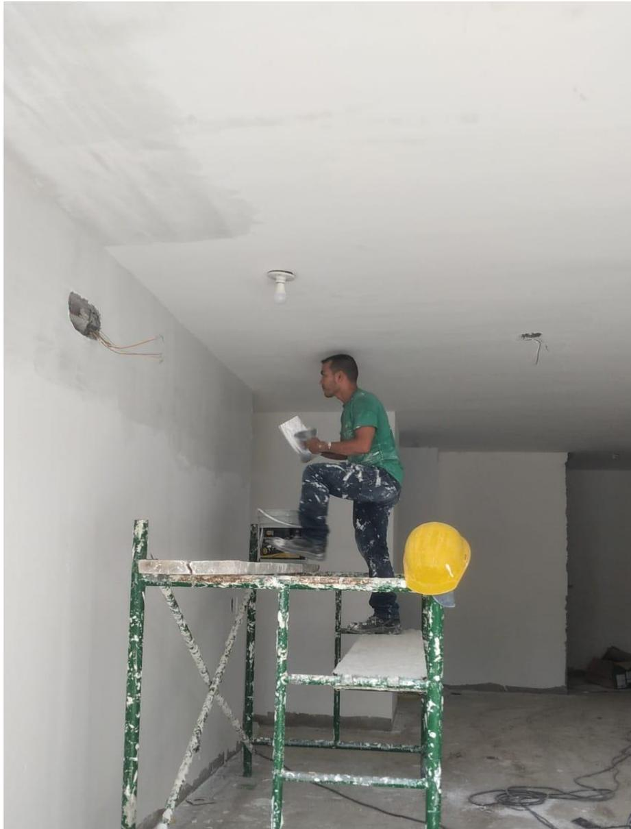
*Ilustración 42. Estuco de muros y techos*
