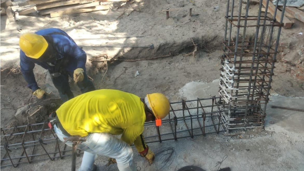
*Ilustración 27. Armado de vigas - Torre de parqueaderos*
