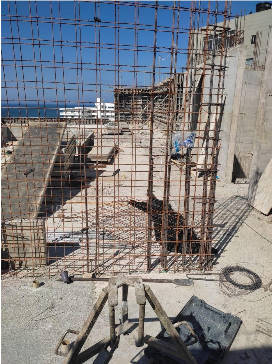
*Ilustración 5. Armado de acero de muros*
