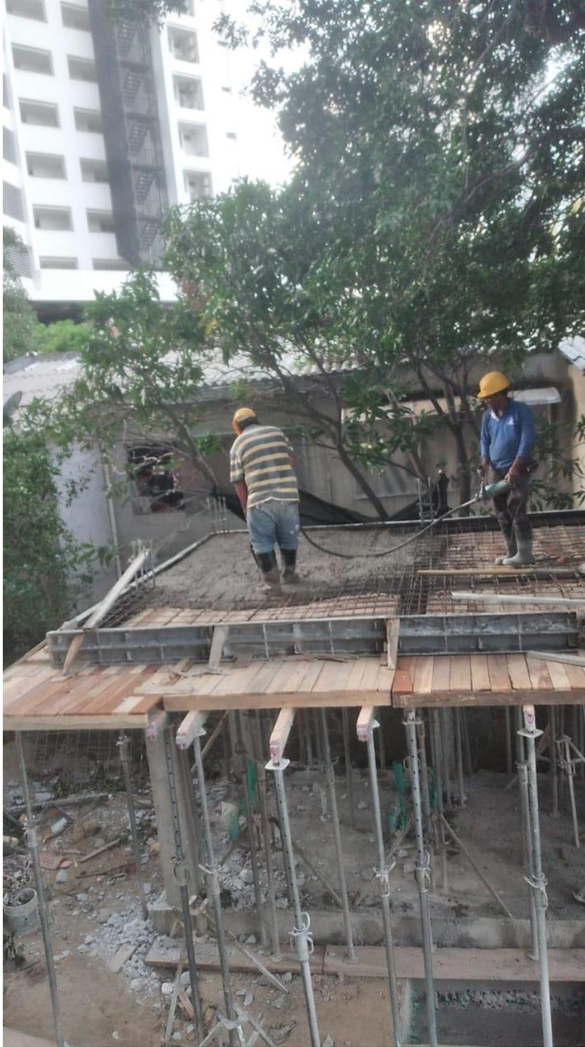
*Ilustración 23. Fundida de placa de subestación*
