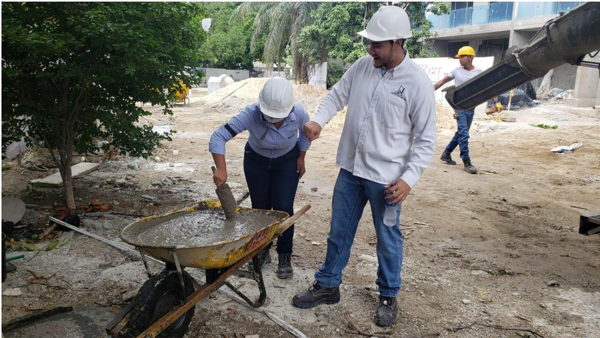
*Ilustración 16. Concreto para prueba de slum*
