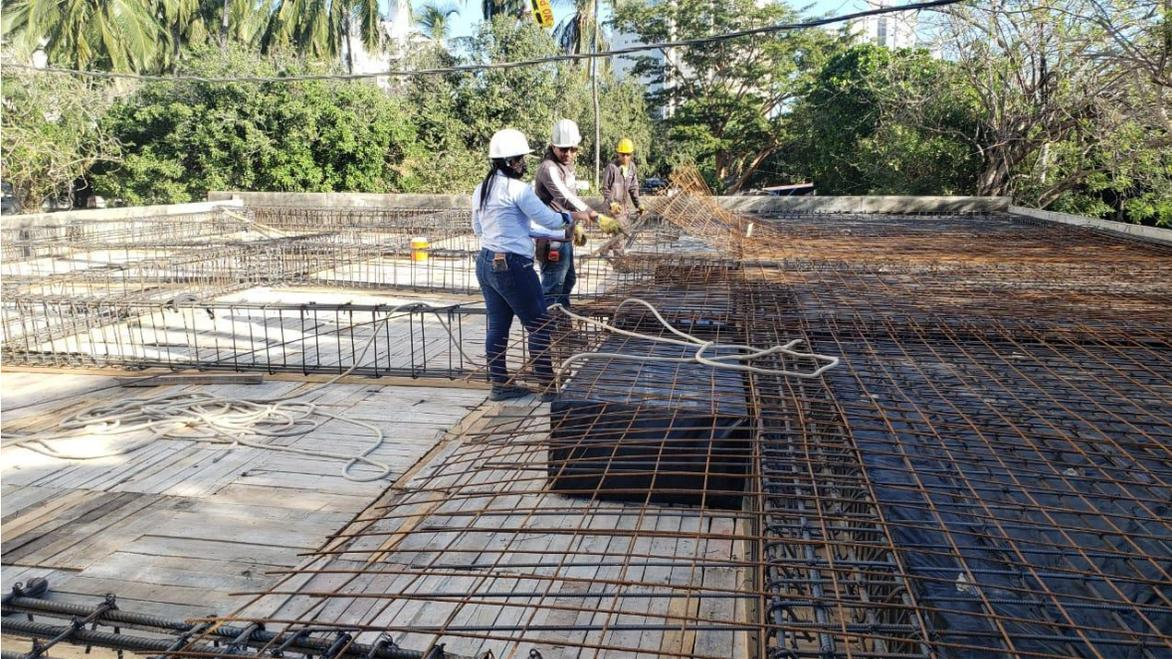
*Ilustración 45. Verificación de armado de placa*
