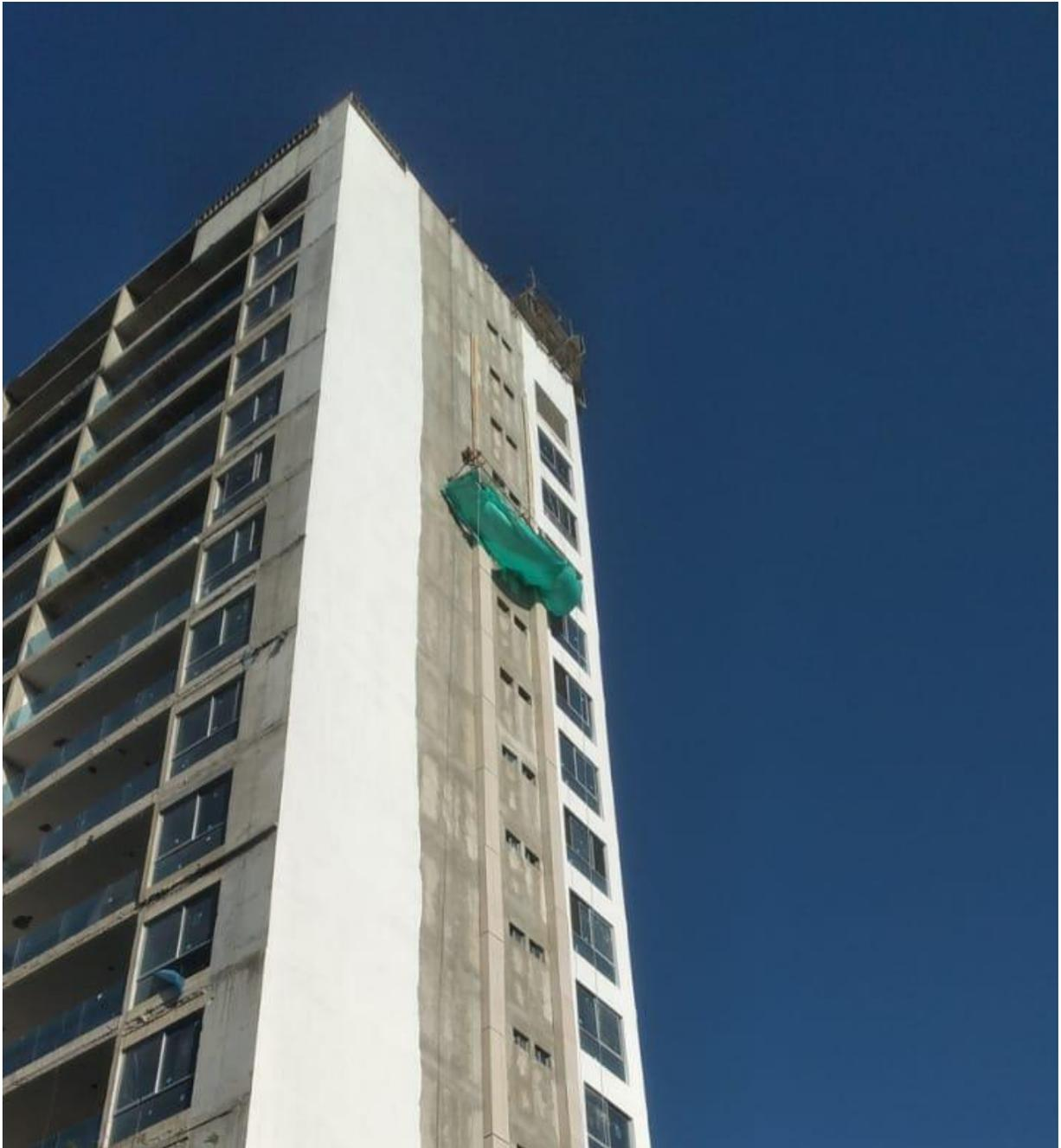
*Ilustración 44. Construcción de buitrones de fachada.*
