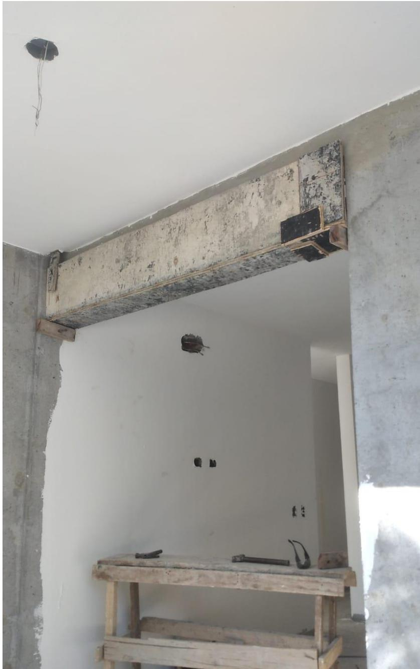
*Ilustración 41. Armado de dinteles*
