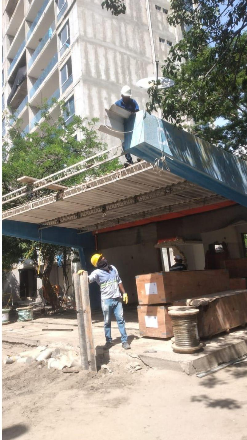
*Ilustración 30. Desmantelamiento de estructura existente*
