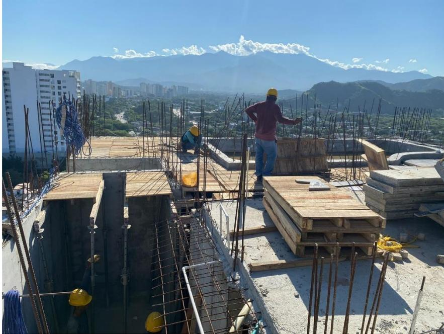
*Ilustración 7. Armado de fondo de placa*
