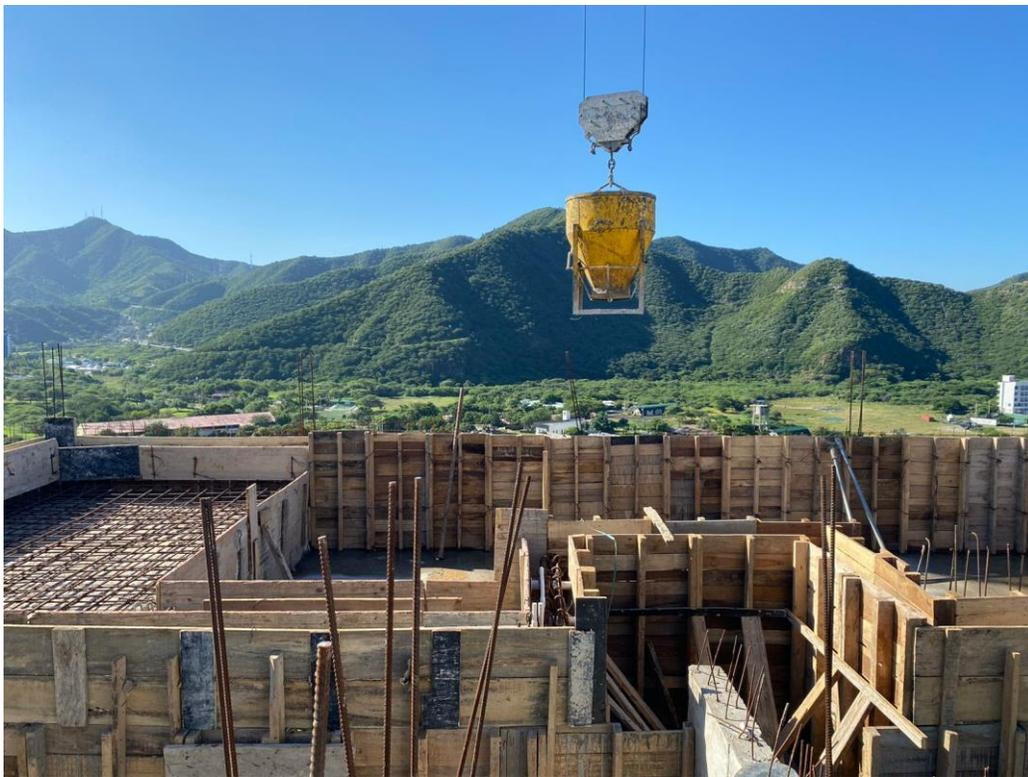
*Ilustración 8. Fundida de muros de piscina*
