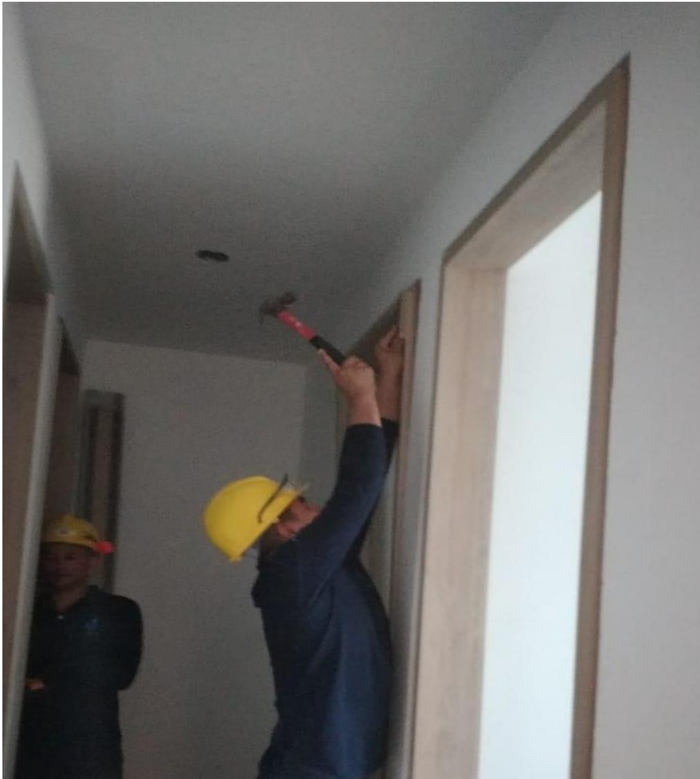
*Ilustración 43. Instalación de carpintería en madera*
