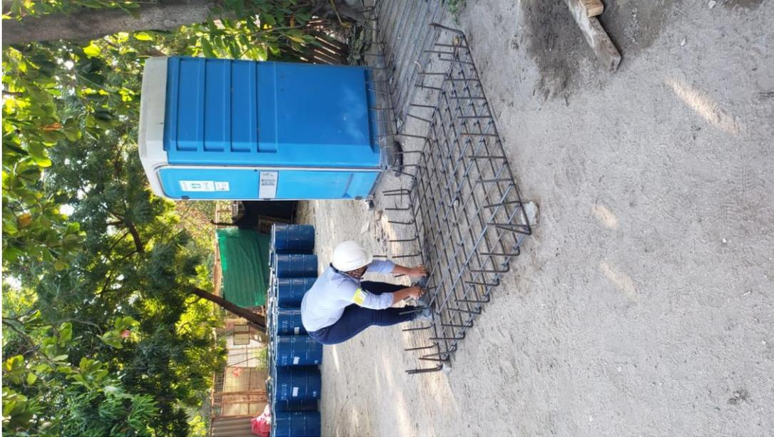
*Ilustración 15. Armado de parrilla para zapatas*
