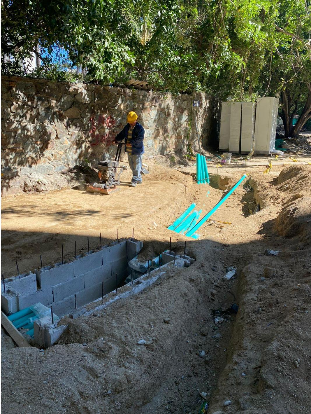
*Ilustración 6. Compactación del terreno para subestación eléctrica*
