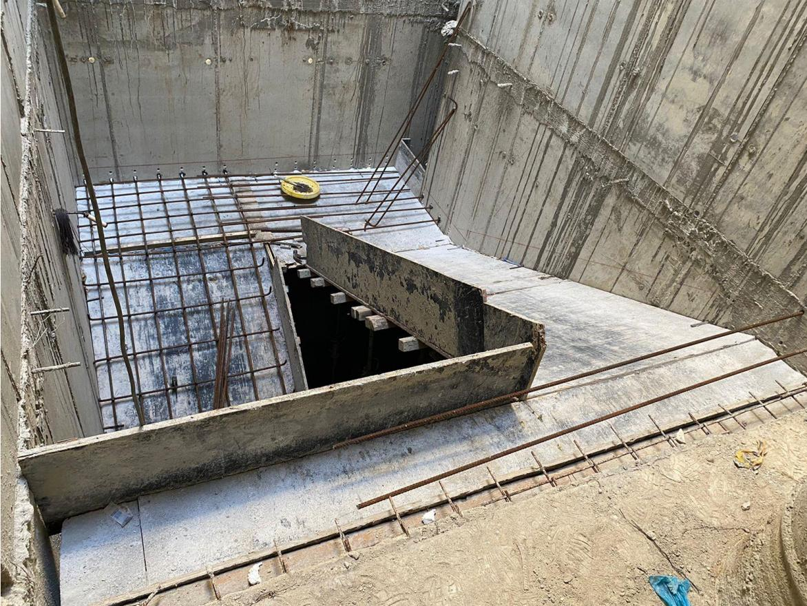
*Ilustración 9. Armado de escaleras*
