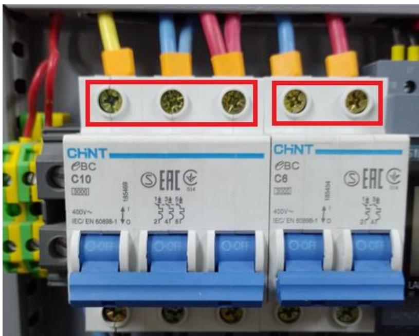
Ilustración 1. Contactos energizados cuando el totalizador y breaker del tablero eléctrico están en ON.
