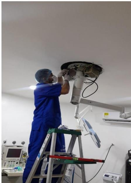
**Ilustración 12 Reparando lámpara cirúrgica**
