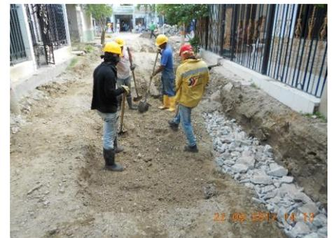
FOTO N°2: Estabilizacion de terreno con piedra clasificada y suelo cemento.
