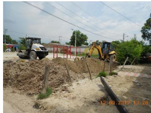
FOTO N°1: Descapote y excavacion de material de sitio.
