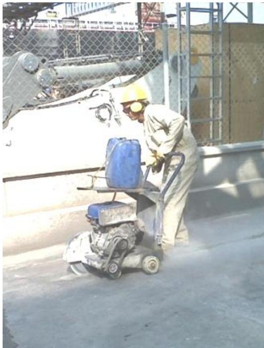
Imagen 11 Demolición de pavimento
