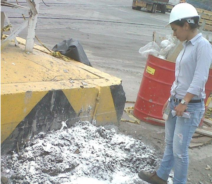
Para el control de malos olores y para minimizar el riesgo biológico proveniente de la extracción de lodos de la cámara de inspección, la estudiante en práctica adicionó CAL, sustancia en polvo que era utilizada como mecanismo preventivo para la manipulación de los mismos.
