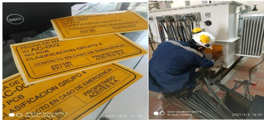
Fotografía 8. Etiquetado de transformadores
