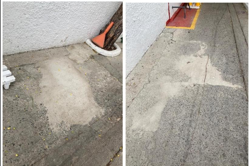
*Anexo 14. Mejora de la condición insegura nivelando el terreno mediante la aplicación de fraguado en deterioro de piso.*
