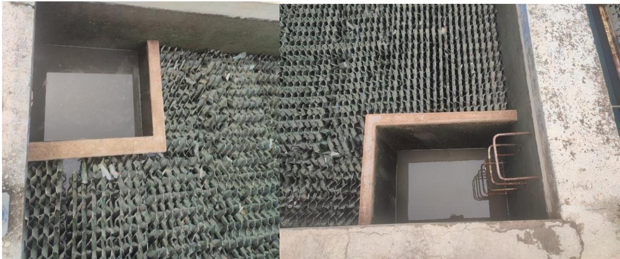
*Imagen N° 16. Sedimentadores vacíos Fuente: propia*
