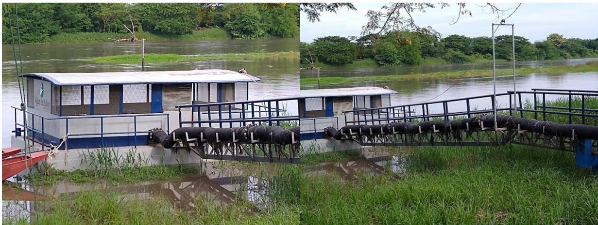
*Imagen N° 6. Barcaza de captación y puente basculante Fuente: propia*
