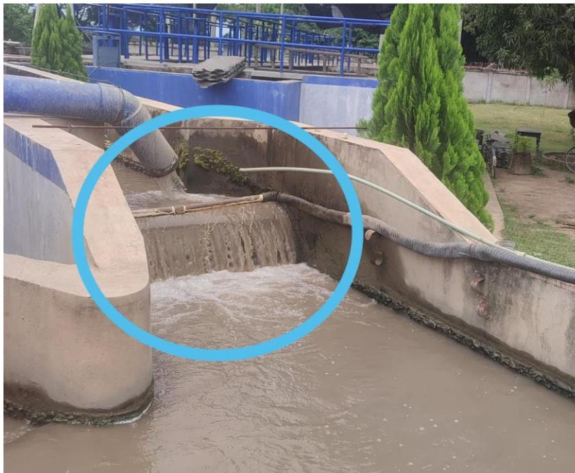
*Imagen N° 12. Tubería tipo flauta Fuente: Propia*
