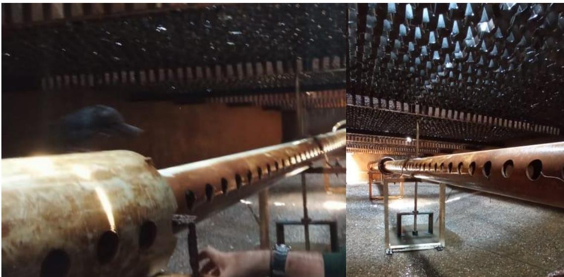
*Imagen N° 19. Tubería al interior del sedimentador Fuente: Propia*
