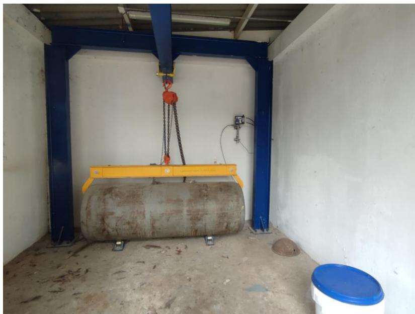
*Imagen N° 22. Contenedor cloro gaseoso de la planta Fuente: propia*
