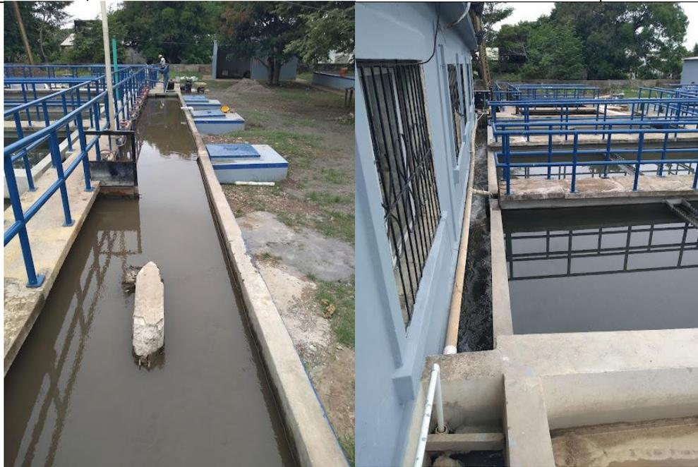
*Imagen N° 18. Canal de reposo entrada de los sedimentadores y canal de recolección de agua sedimentada Fuente: propia*
