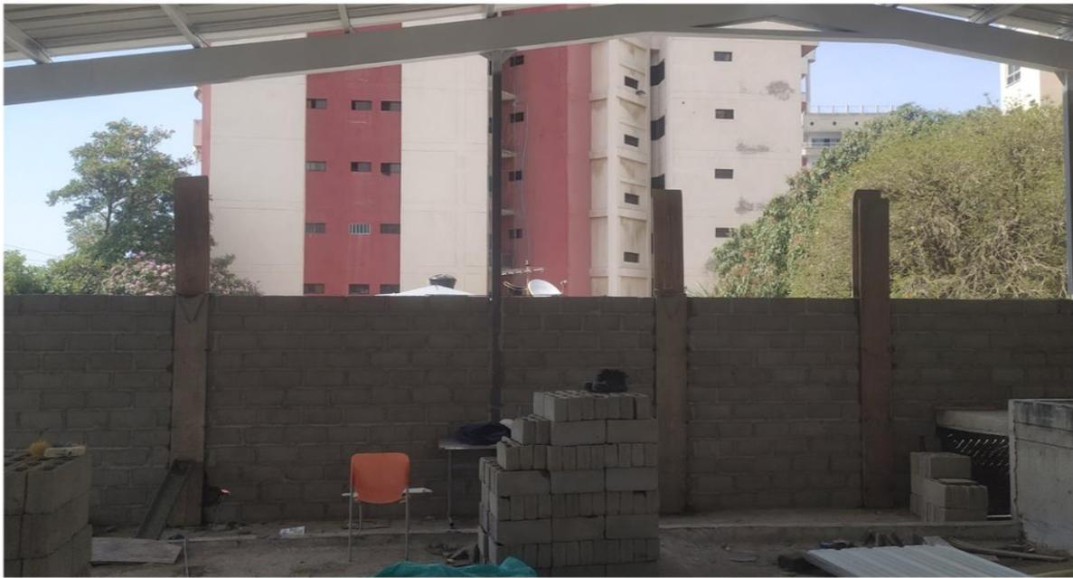
*Ilustración 69. levante de muros y fundida de columnetas*
