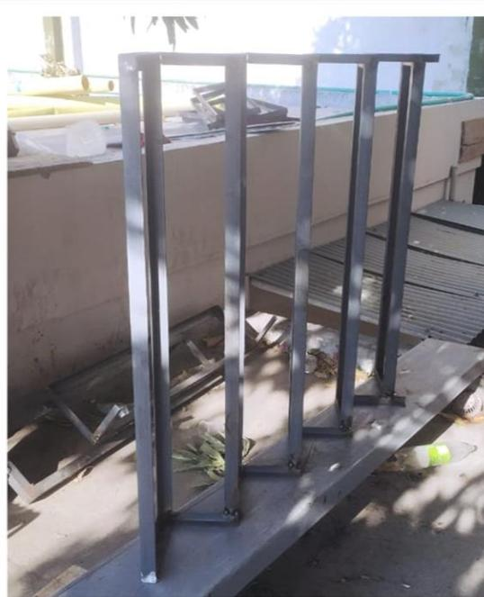
*Ilustración 37. armado y soldadura de la escalera*
