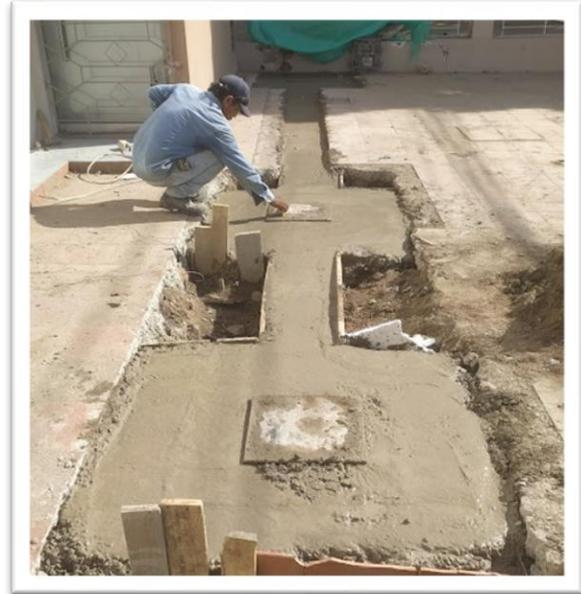
*Ilustración 31. zapatas fundidas*
