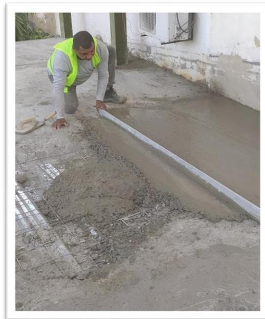
*Ilustración 40 fundida de placa segundo piso*
