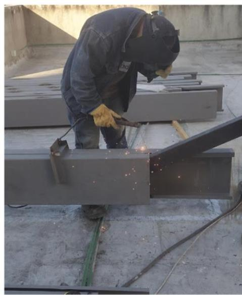
*Ilustración 36. soldadura de las vigas de la cubierta*
