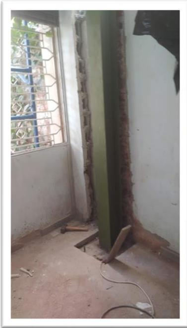
*Ilustración 26. instalación de columnas metálicas*
