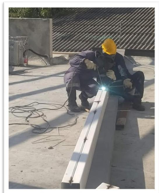
*Ilustración 44. empalme y encajonamiento de correas de la cubierta*
