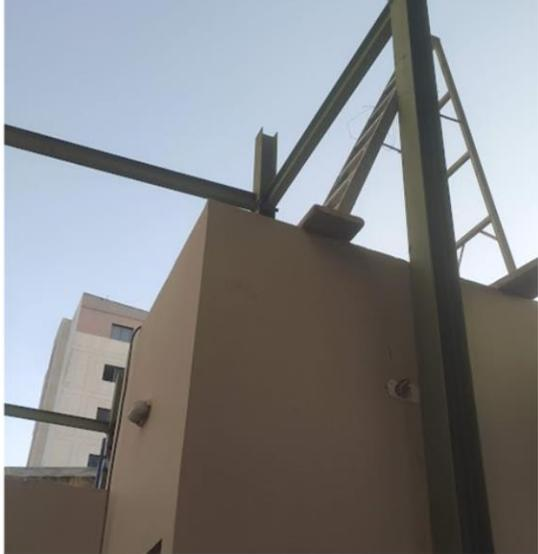
*Ilustración 35. estructura metálica para placa de tanques*
