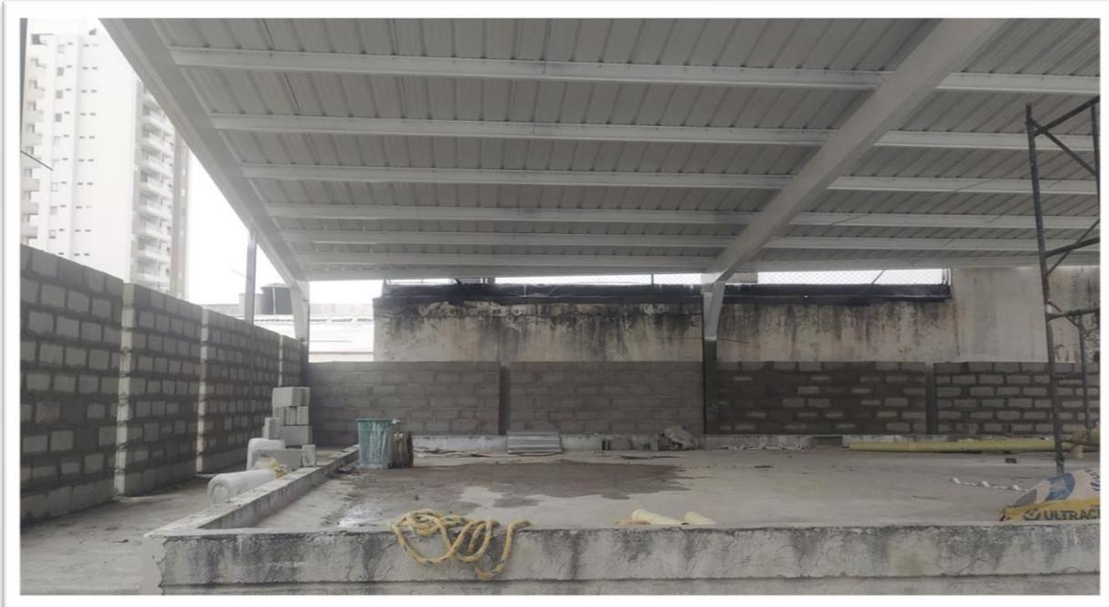
*Ilustración 63. cerramiento de muros de segundo piso*
