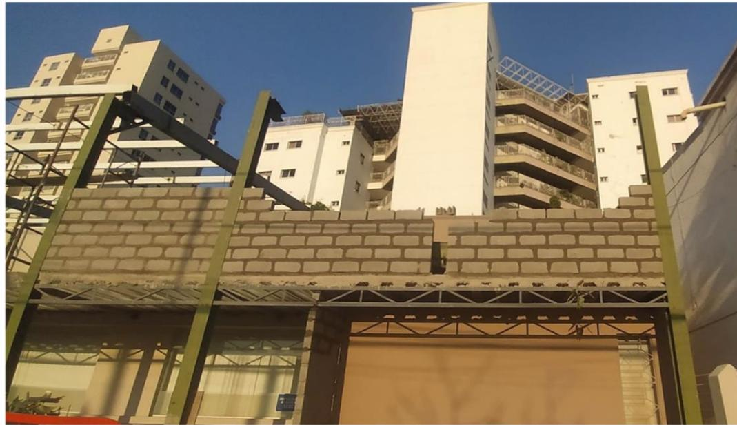
*Ilustración 54. levante de muros en la fachada izquierda*
