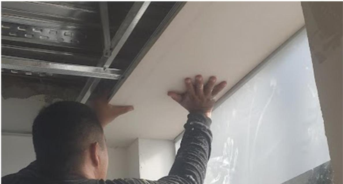
*Ilustración 73. encajonamiento en drywall de columnetas y vigas*
