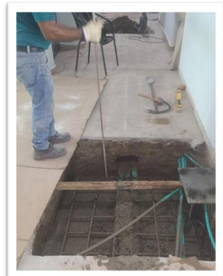
*Ilustración 27. fundida de zapatas*
