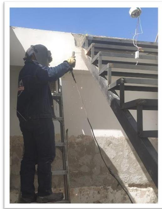
*Ilustración 42. soldadura de la escalera*
