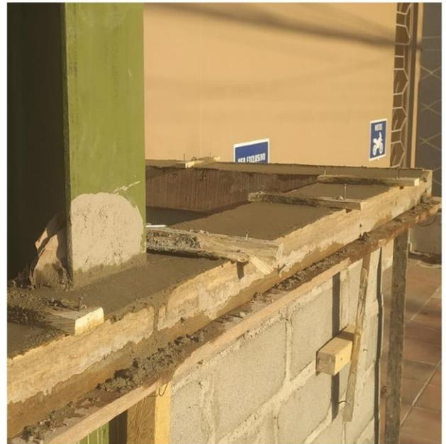
*Ilustración 52. fundida de viga*
