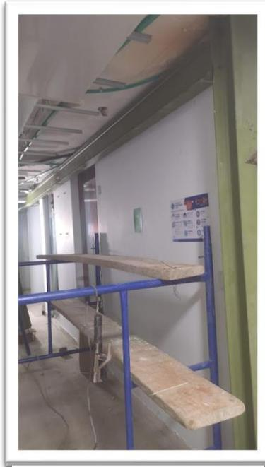
*Ilustración 29. columnas y viga de refuerzo de placa*
