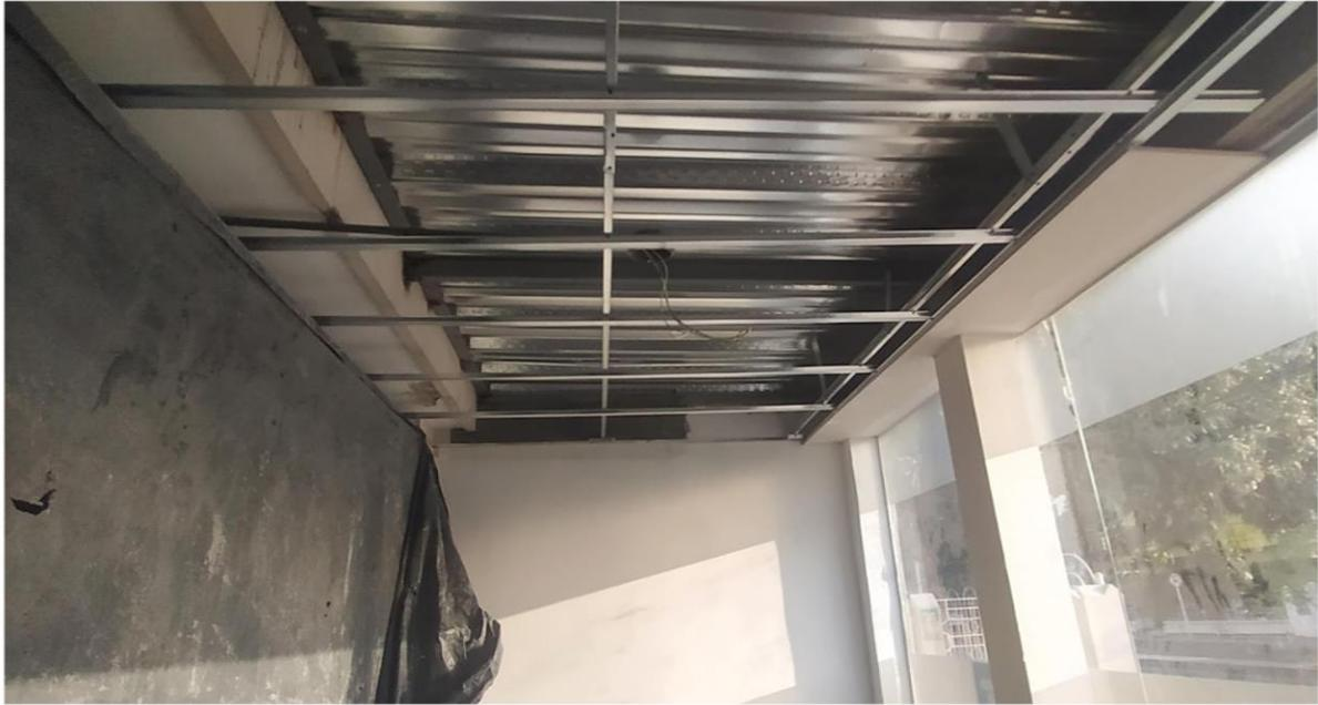
*Ilustración 72. estructura metálica para techo en PVC*
