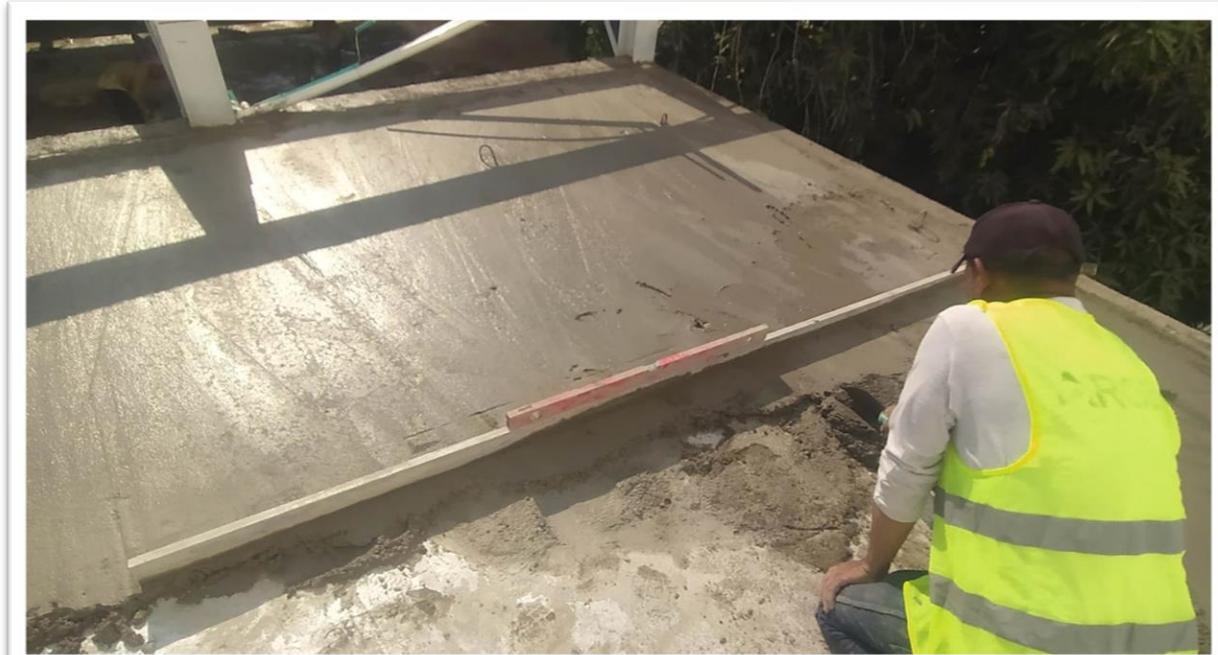
*Ilustración 67. fundida de plantilla de nivelación*
