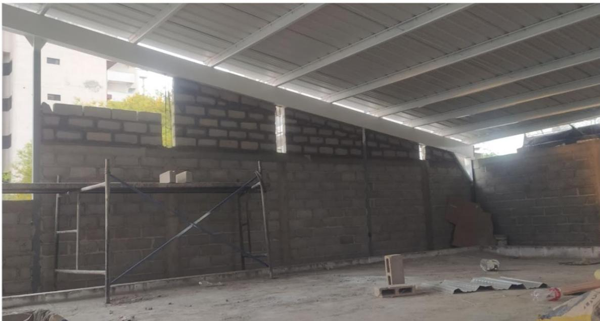
*Ilustración 68. levante de muros en cuchilla*
