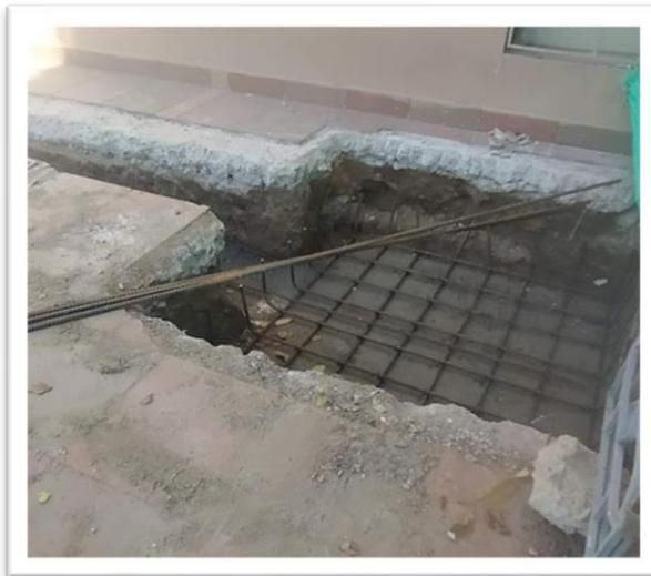
*Ilustración 30. armado de acero de refuerzo para las zapatas*
