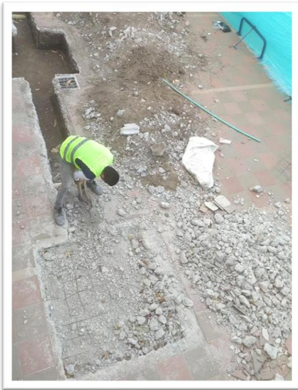
*Ilustración 22. excavación de zapatas*
