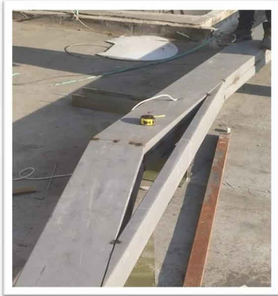
*Ilustración 46. armado de refuerzo de viga para la cubierta*
