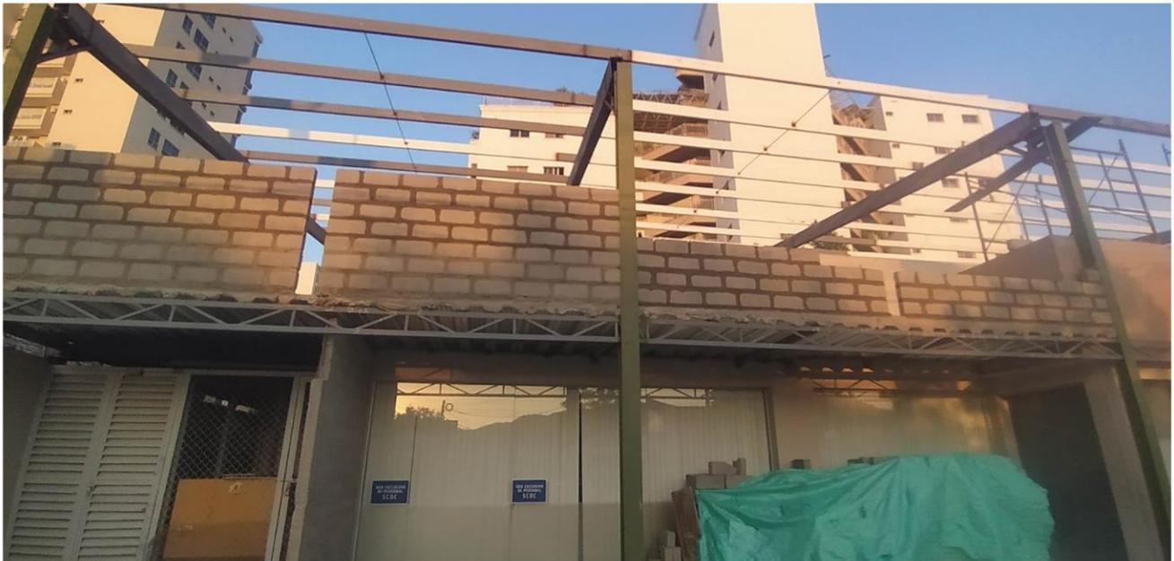
*Ilustración 55. levante de muros en la fachada*
