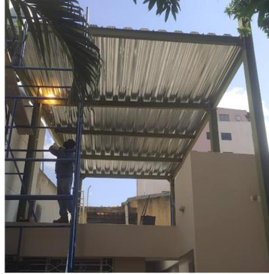
*Ilustración 34. soldadura e instalación de metaldeck*
