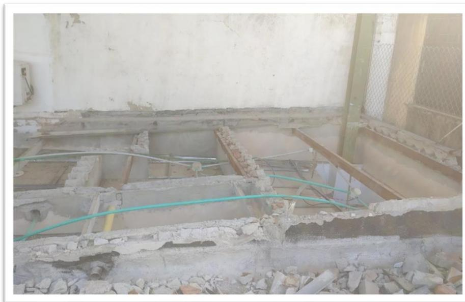
*Ilustración 20. desmonte y demolición de cubierta existente*
