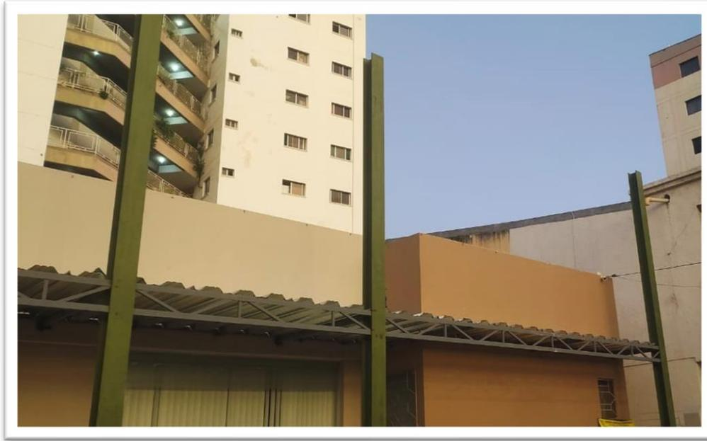
*Ilustración 38. columnas para soporte de la cubierta*
