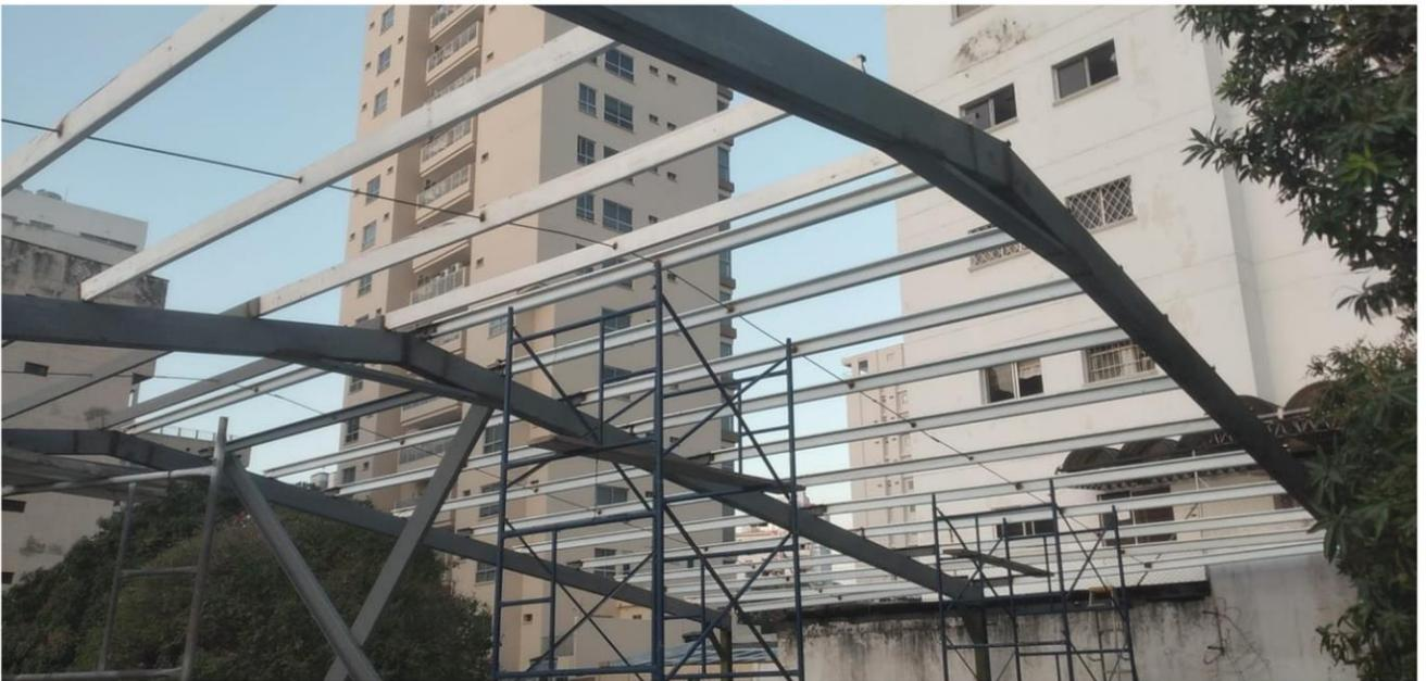
*Ilustración 57. estructura metálica de la cubierta*
