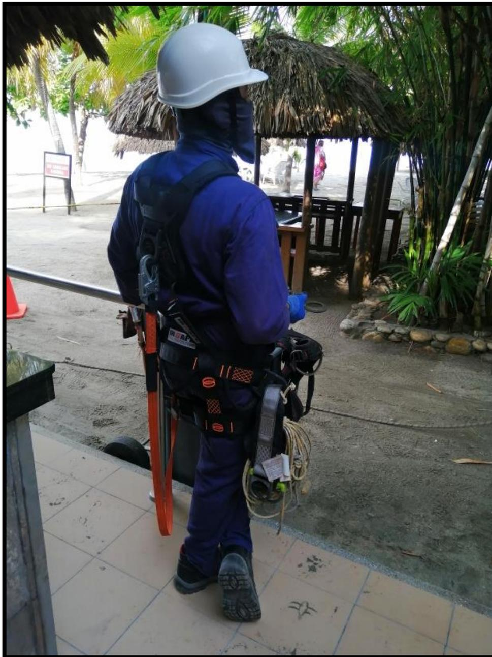
*Figura 22: Revisión al trabajador del cumplimiento del uso de elementos de protección personal y sistemas contra caídas*
