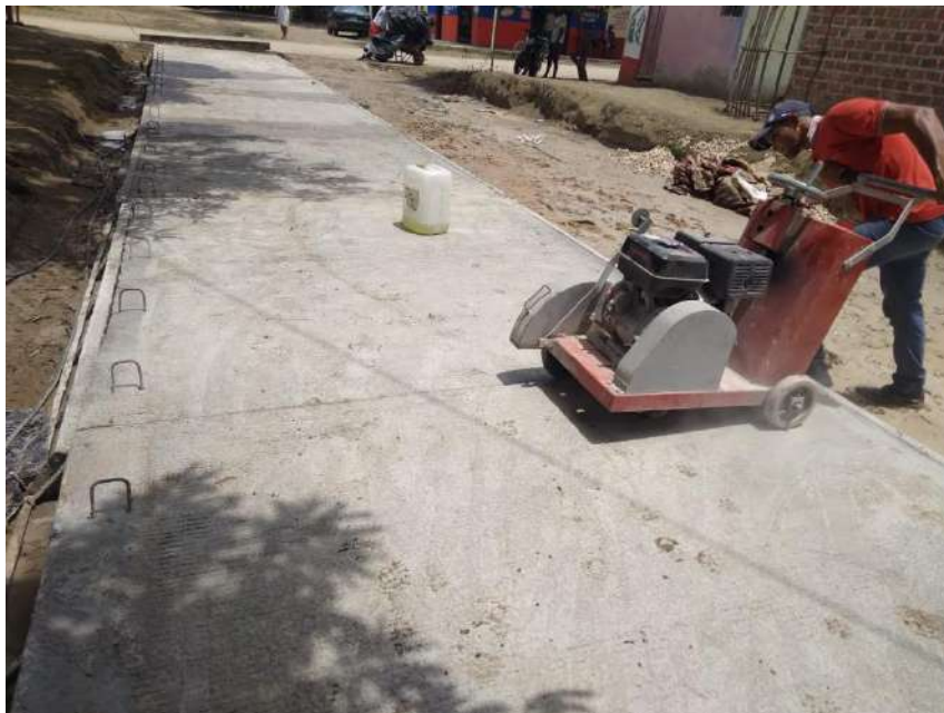
Imagen 8: Corte de placas para juntas de dilatación.
