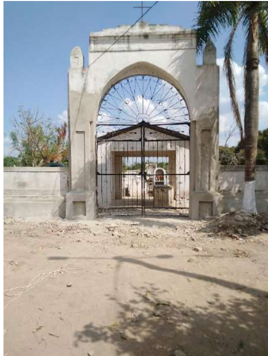
Imagen 11: Fallada del cementerio antes de ser intervenida.
