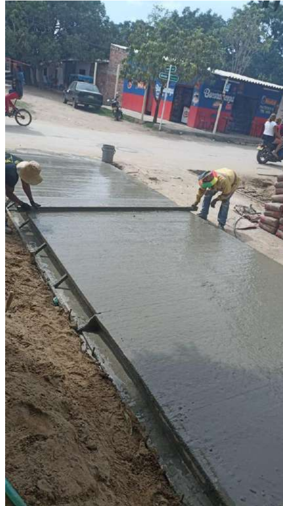
Imagen 4: Allanado de las placas de concreto, para posteriormente continuar con el proceso de rayado.
