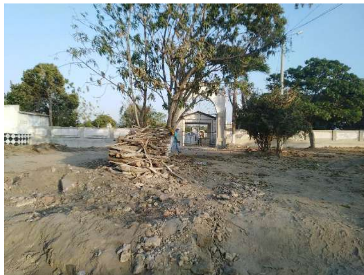
Imagen 12: Limpieza del área a intervenir
