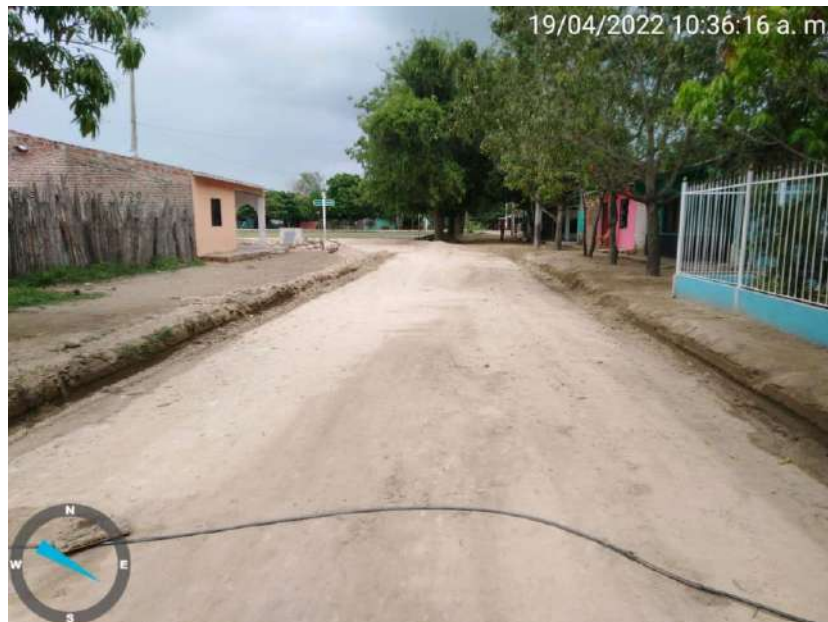
Imagen 2: Terreno Conformado y Compactado
