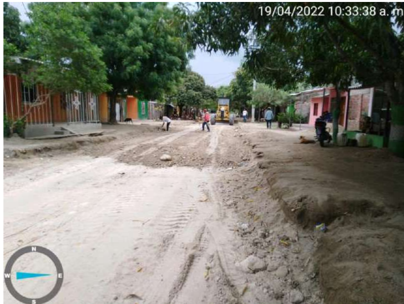
Imagen 1: Nivelación de terreno con Motoniveladora
