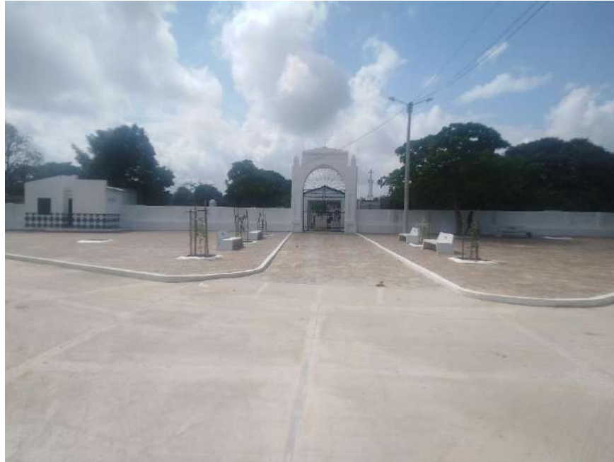
Imagen 13: Fallada del cementerio después de ser intervenida.
