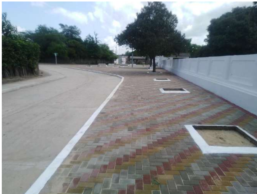
Imagen 14: Adecuación de acceso peatonal
