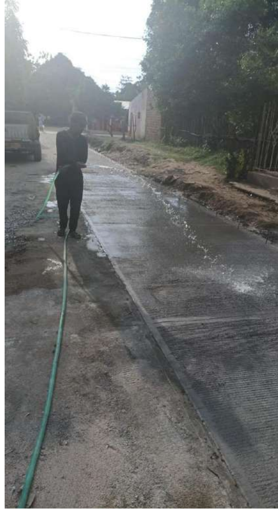
Imagen 6: Proceso de curado de concreto.
