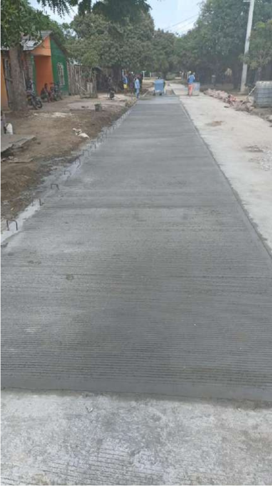
Imagen 5: Calzada completa fundida y acabada
