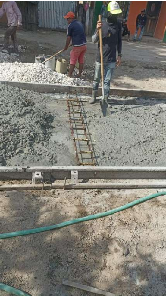
Imagen 3: Construcción de placas de concreto hecho en obra.
