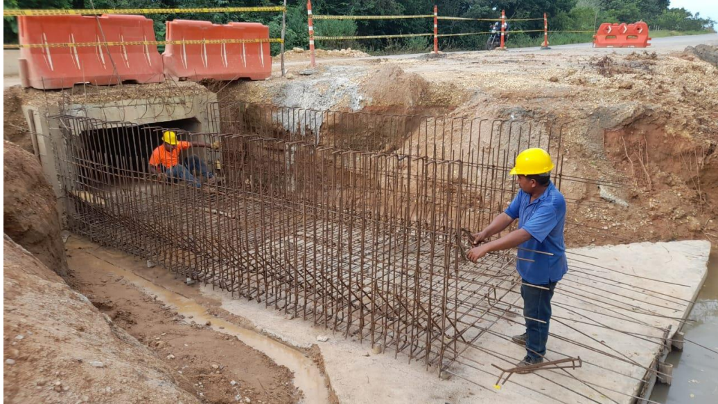
Imagen 2. Figurado de acero para Box Culvert localizado en K24+470.
