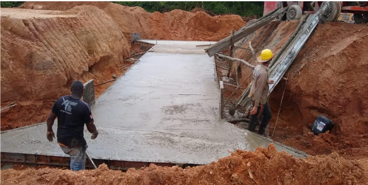
Imagen 1. Foto vaciado placa de concreto para Box Culvert localizado en K24+470.
